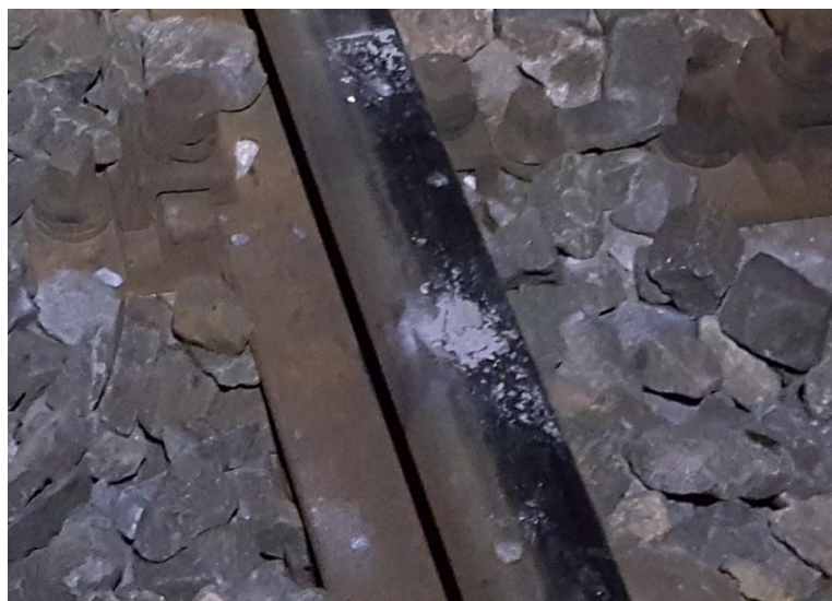
Imaginea nr. 7 : resturi de piatră spartă, sfărâmată de roți
