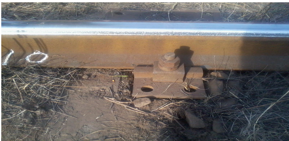
Foto 1. Locul în care s-a produs cățărarea buzei roții din partea dreaptă sens de mers a osiei pe ciuperca șinei corespunzătoare firului exterior al curbei.
