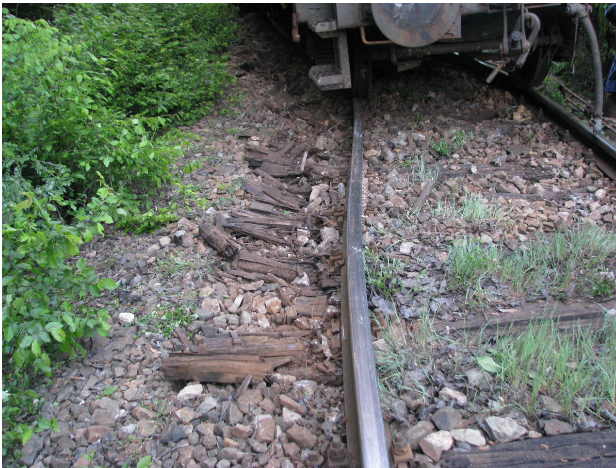
Figura 3 - deformațiile provocate la linie de către vagoane în timpul deraierii
