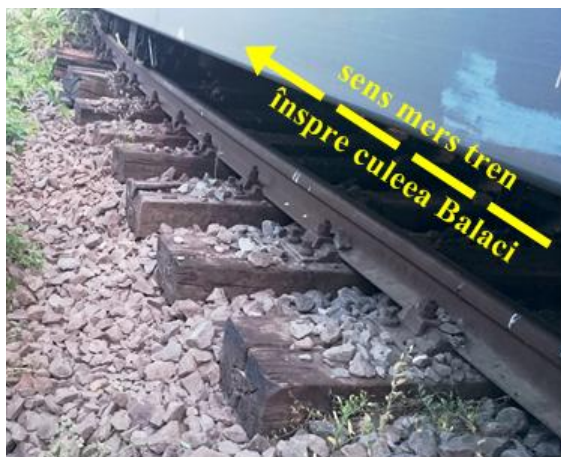
piatră spartă insuficientă între traverse
