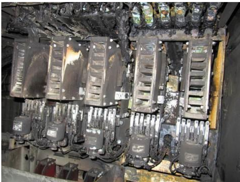
Foto nr.2 – Contactori electropneumatici și cablajul aferent - bloc S4
