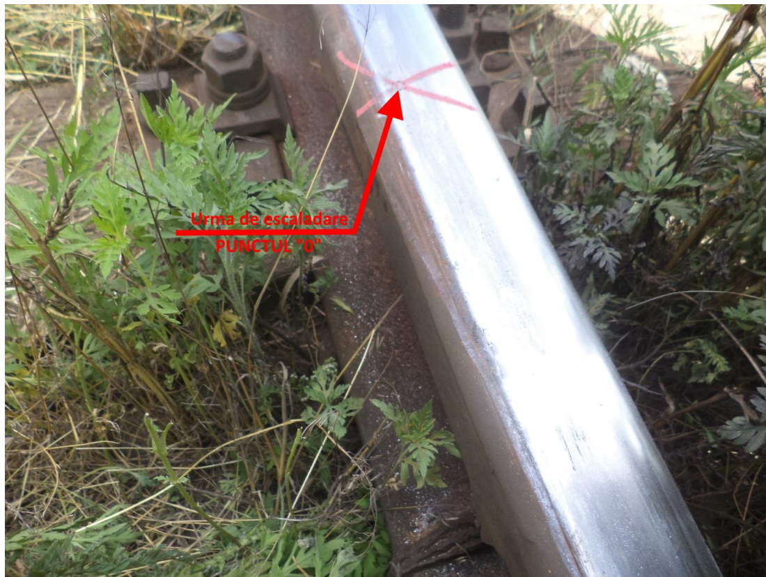
Fig. 5 – urma de escaladare a buzei bandajului pe ciuperca șinei pag.9 din 27
