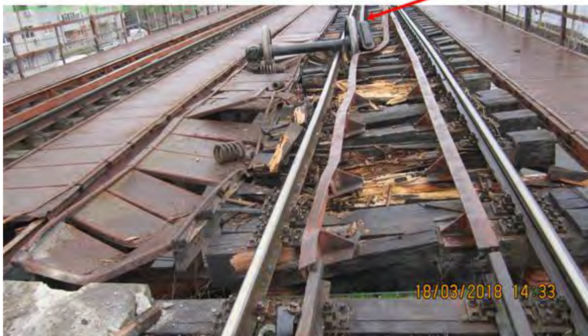
Fig. 6 – podul cu osia ieșită de la vagon
