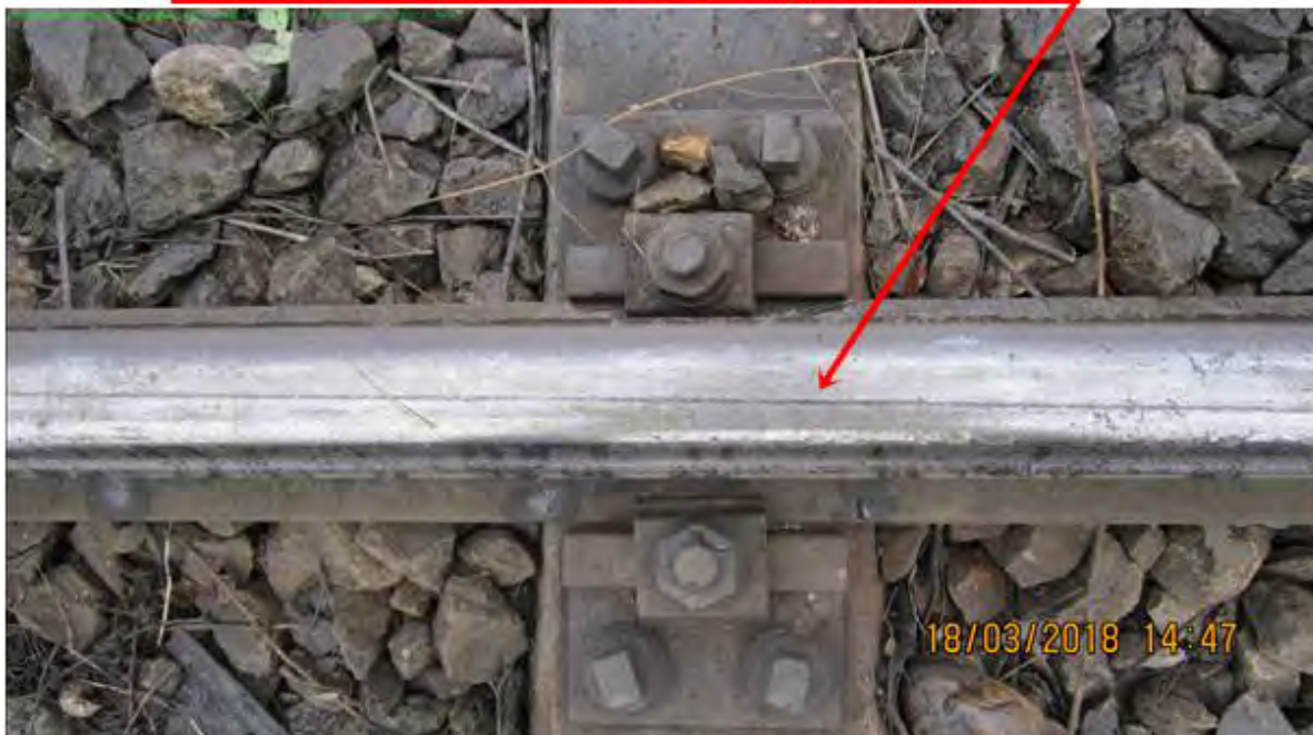
Fig. 5 – urmă de rulare a buzei unei roți pe suprafața superioară al ciupercii șinei
