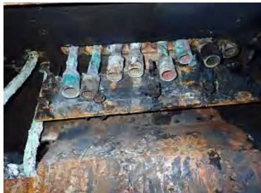
Foto nr.2 conectorii tip tulipă (M) din blocul S4
