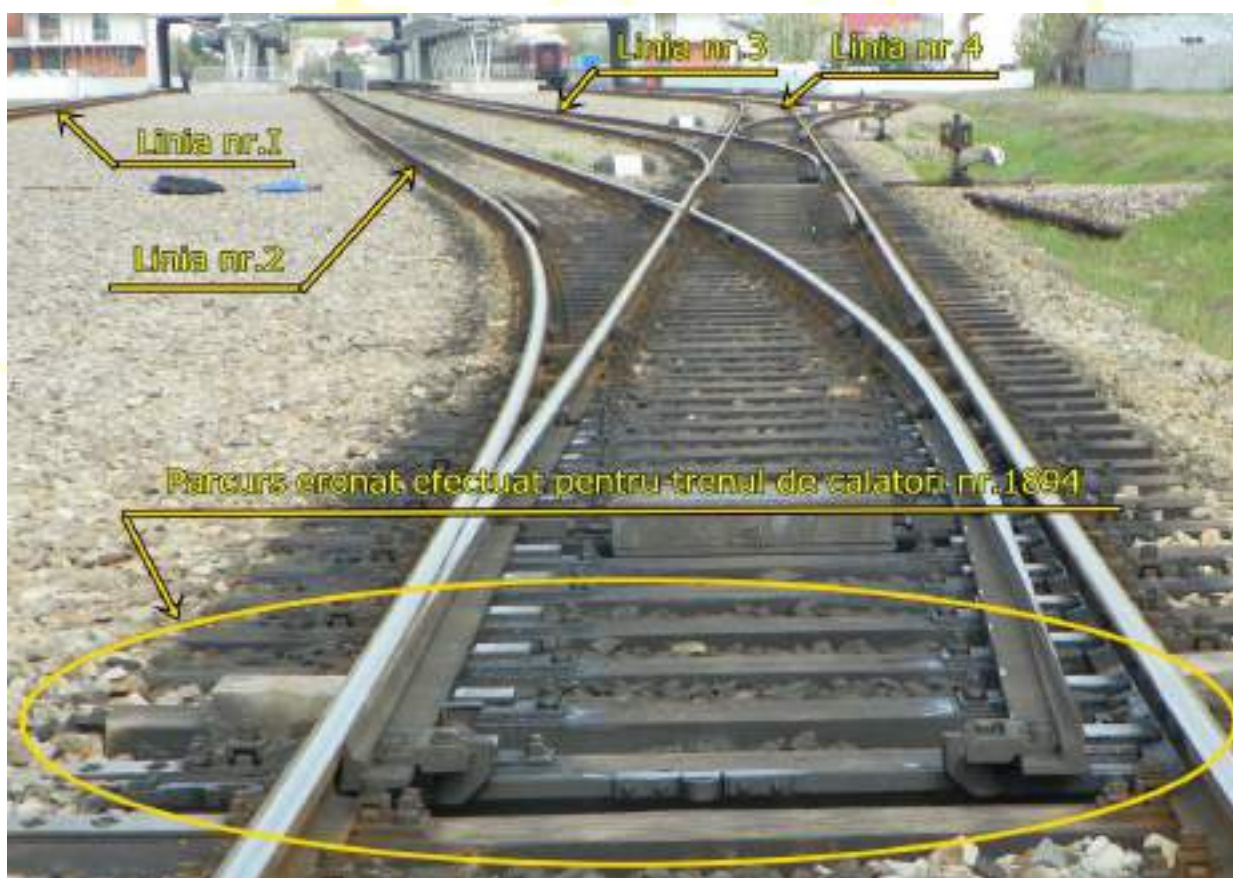
Fig.2 Poziția acelor macazului schimbătorului de cale nr.25
