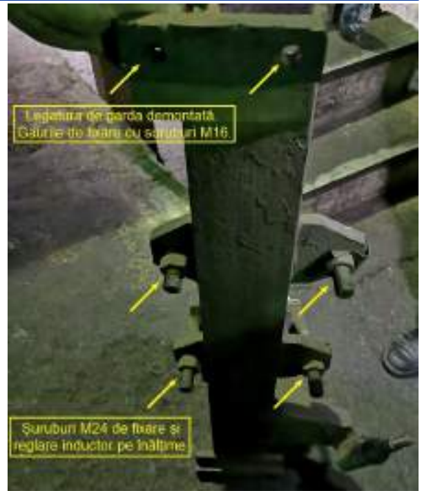
Foto nr.8 - Placa de legătură de gardă pe care a fost montat inductorul avariât
