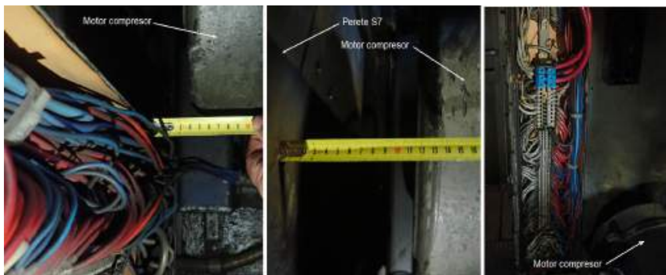
Foto nr.7: Distanța de la caseta rulmentului la blocul de aparate S7 și la placa de borne.
