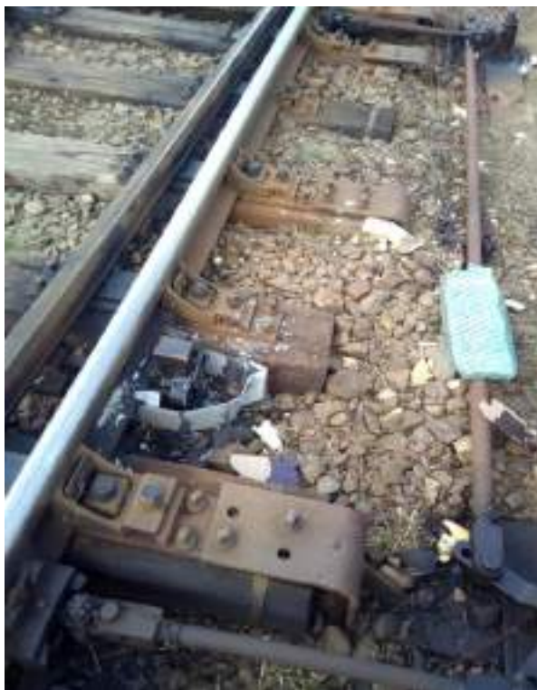
Foto nr.1 – Cutia de protecție a încuietorii macaz nr.1 distrusă. Resturi din inductorul locomotivei
