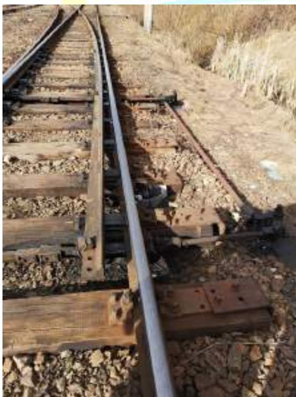
Foto nr.3 – Dispozitivul de acționare al încuietorii macazului nr.1, cu cutia de protecție a distrusă
