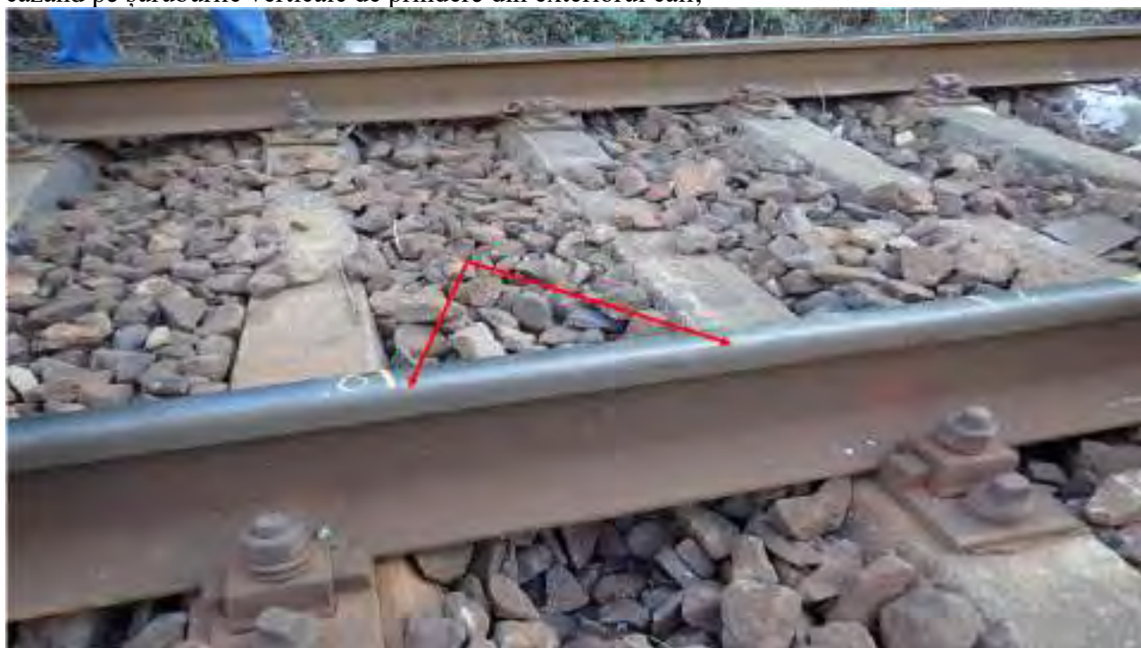
foto 11: urma de cădere a roții în exteriorul căii
