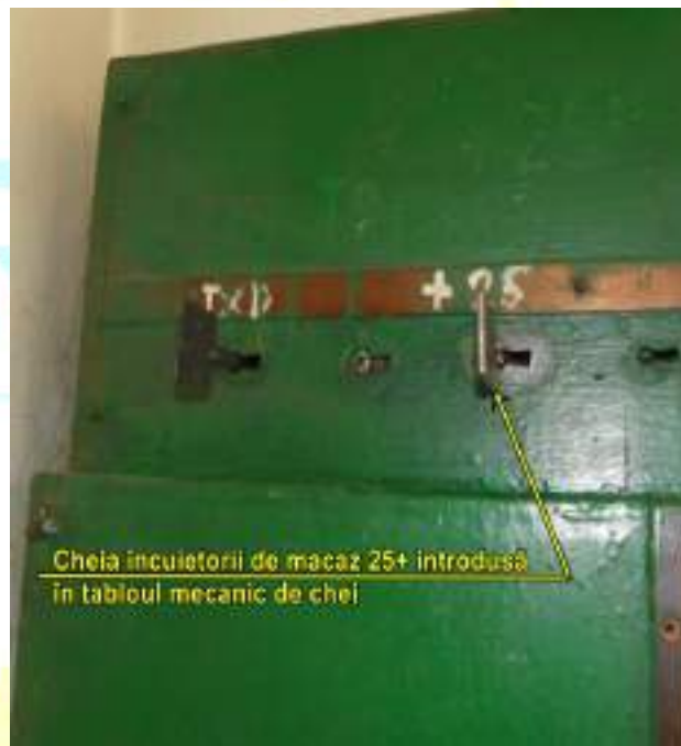
Fig. 6 Partea superioară a tabloului mecanic de chei de la cabina nr.3
