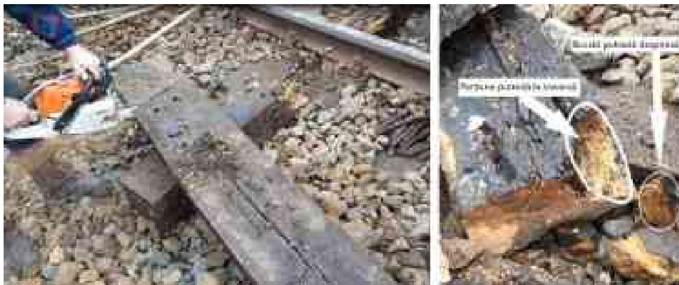
Imaginea 9 - Traversa înainte de secționare ; Porțiuni putrede care se desprindeau la manipulare;
