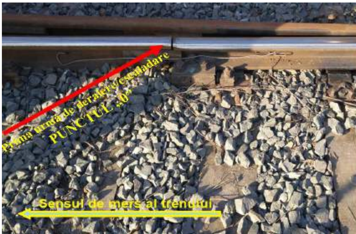
Fotografia nr.1 – Prima urmă de deraiere produsă prin escaladarea șinei de legătură curbă a schimbătorului nr.18 (deviație de stânga) - stația CFR Săvârșin
