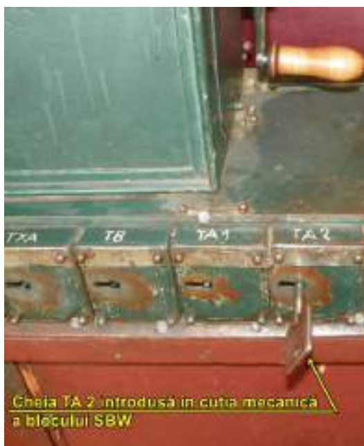
Fig. 9 Cutia mecanică a blocului SBW partea cu încuietori chei de la cabina nr.3
