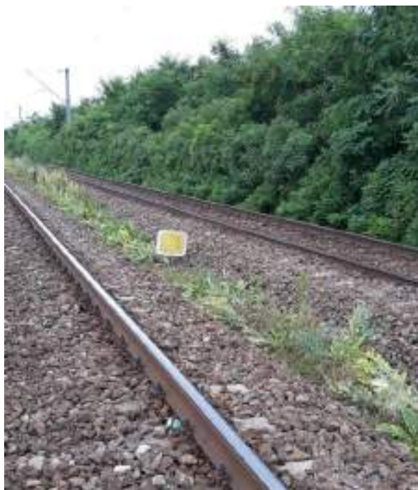
Fig. 2 Paleta cu fața galbenă spre tren pentru restricția de viteză de la km 76+650 la km 76+550
