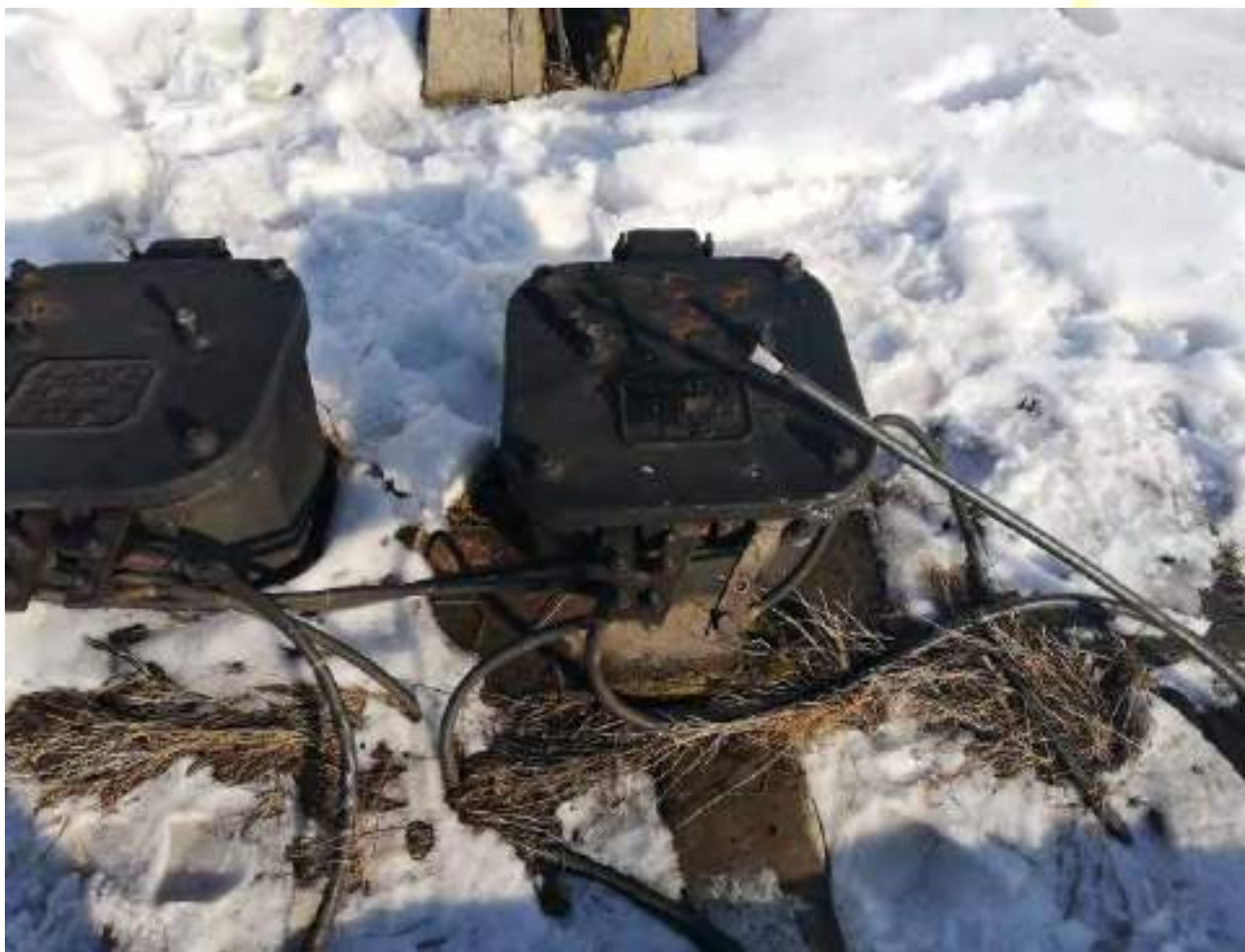
Foto nr.6 – Bobina de joantă (din dreptul semnalului BL17 de la km.367 +850 ) lovită, cabluri smulse
