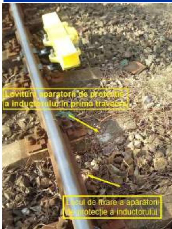
Foto nr.5 – Inductorul din cale nou montat – Urme de lovituri pe traversă, ale apărătorii distruse și desprinsă din legătura de pe șină. Între traversele 2 și 3 dinspre inductor, se văd urmele prinderii apărătorii de protecție pe șină
