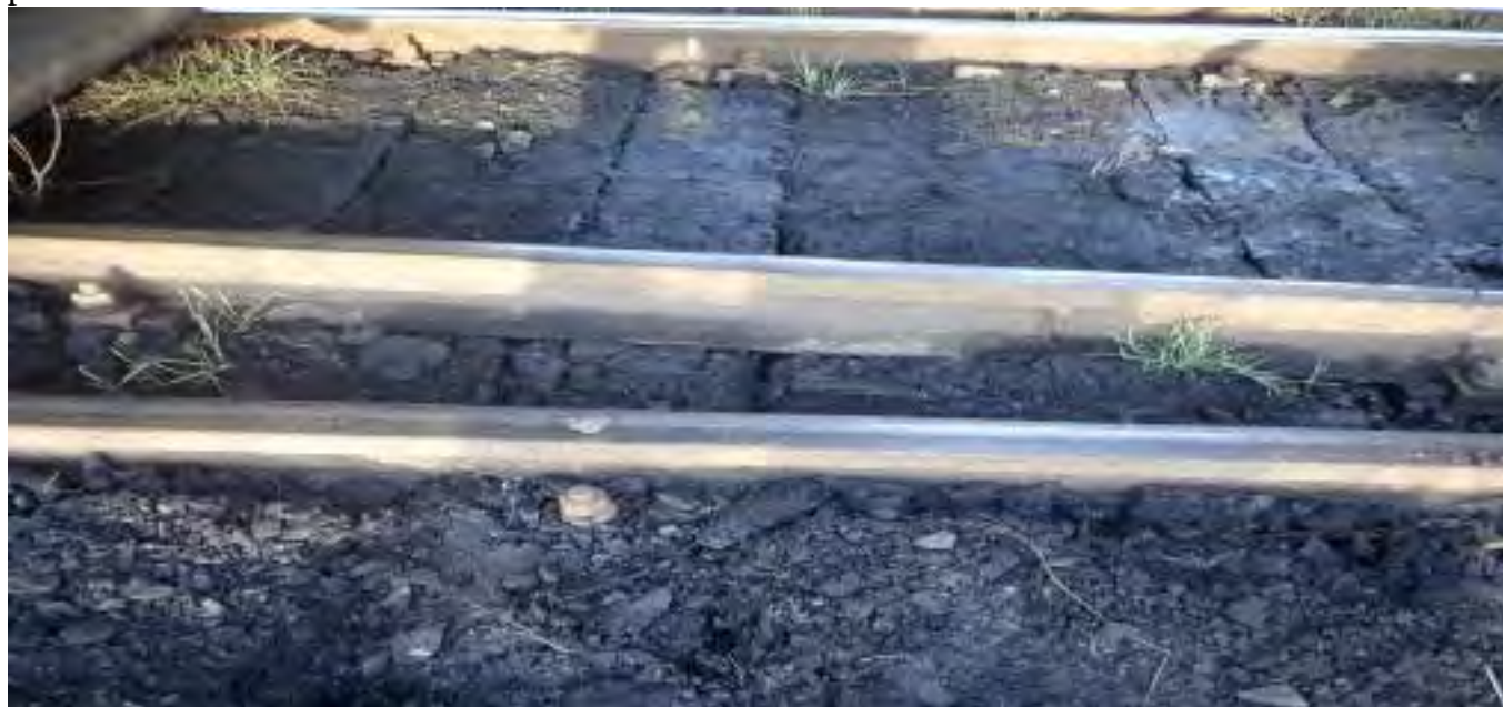
foto nr. 4: starea prisme de piatră spartă pe zona producerii accidentului
