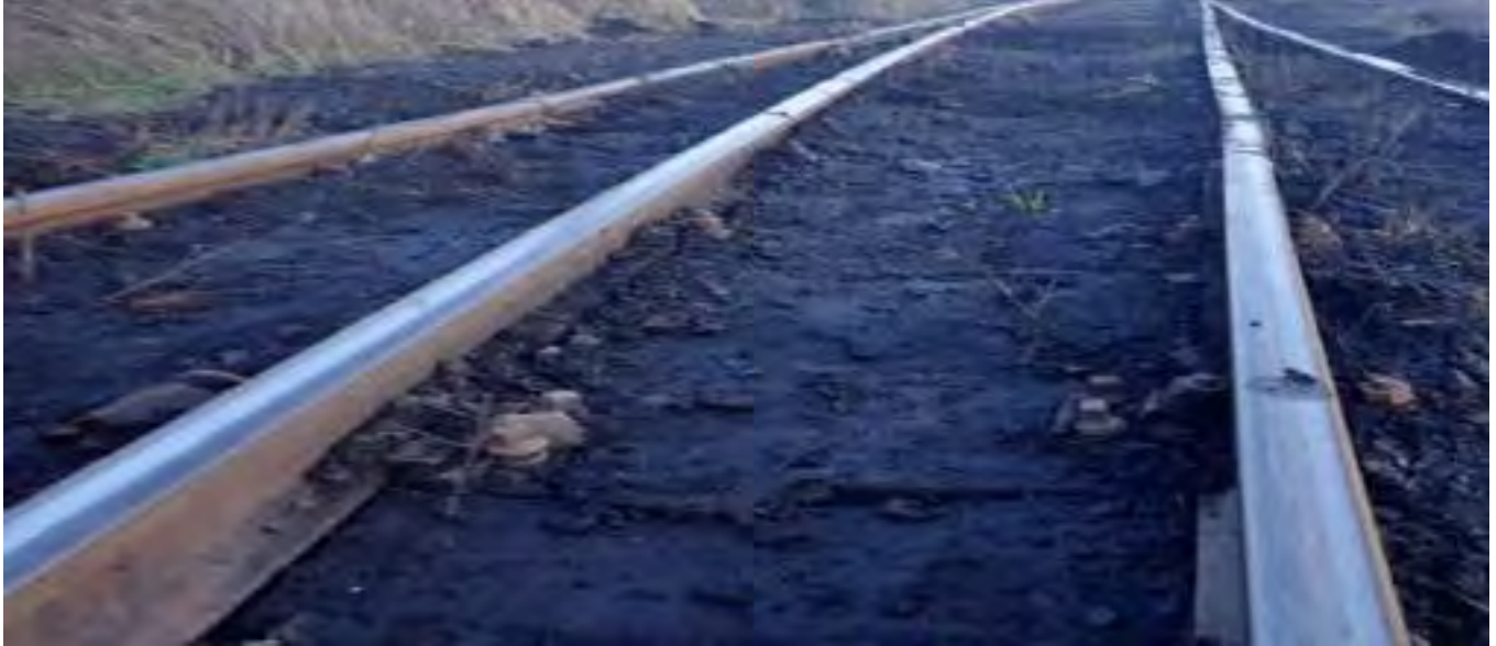
foto nr. 10: prisma de piatră spartă pe zona producerii accidentului
