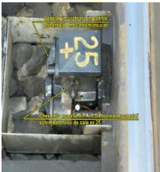
Fig. 5 Încuietoria de macaz 25+ a schimbătorului de cale nr.25
