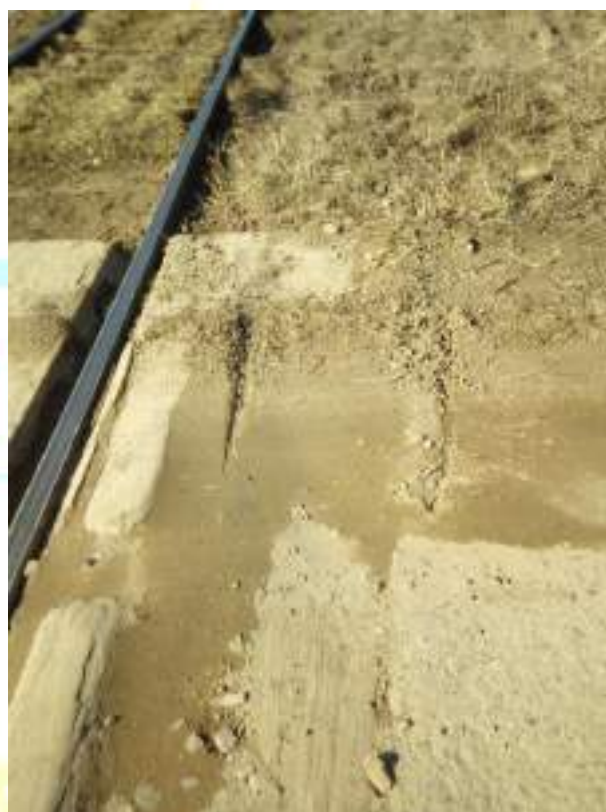
Foto nr.10 – Urme de lovituri în pasajul trecerii la nivel cu calea ferată de la km. 20 +686
