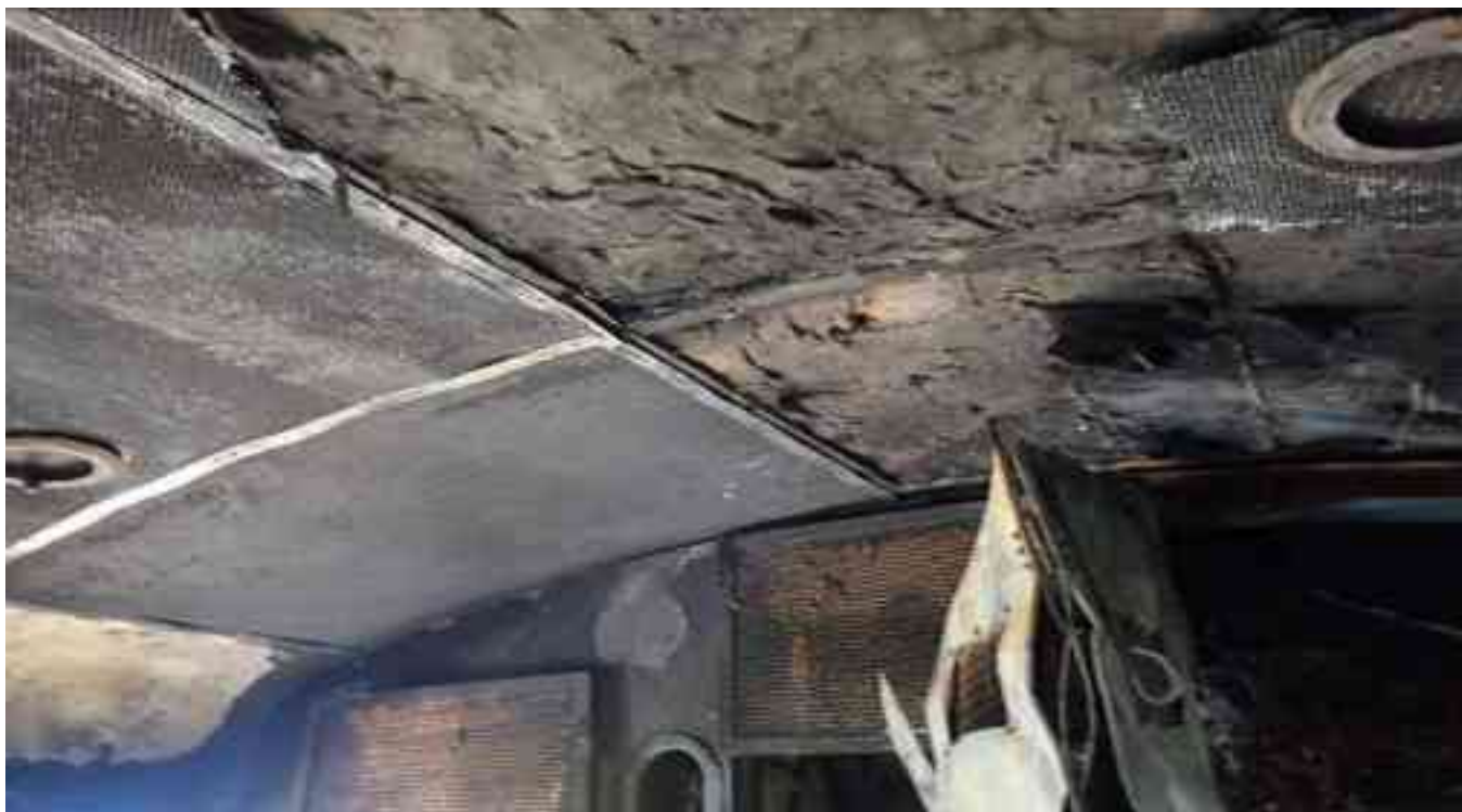
Foto nr.6 – Plăci tavan deformate și degradate.
