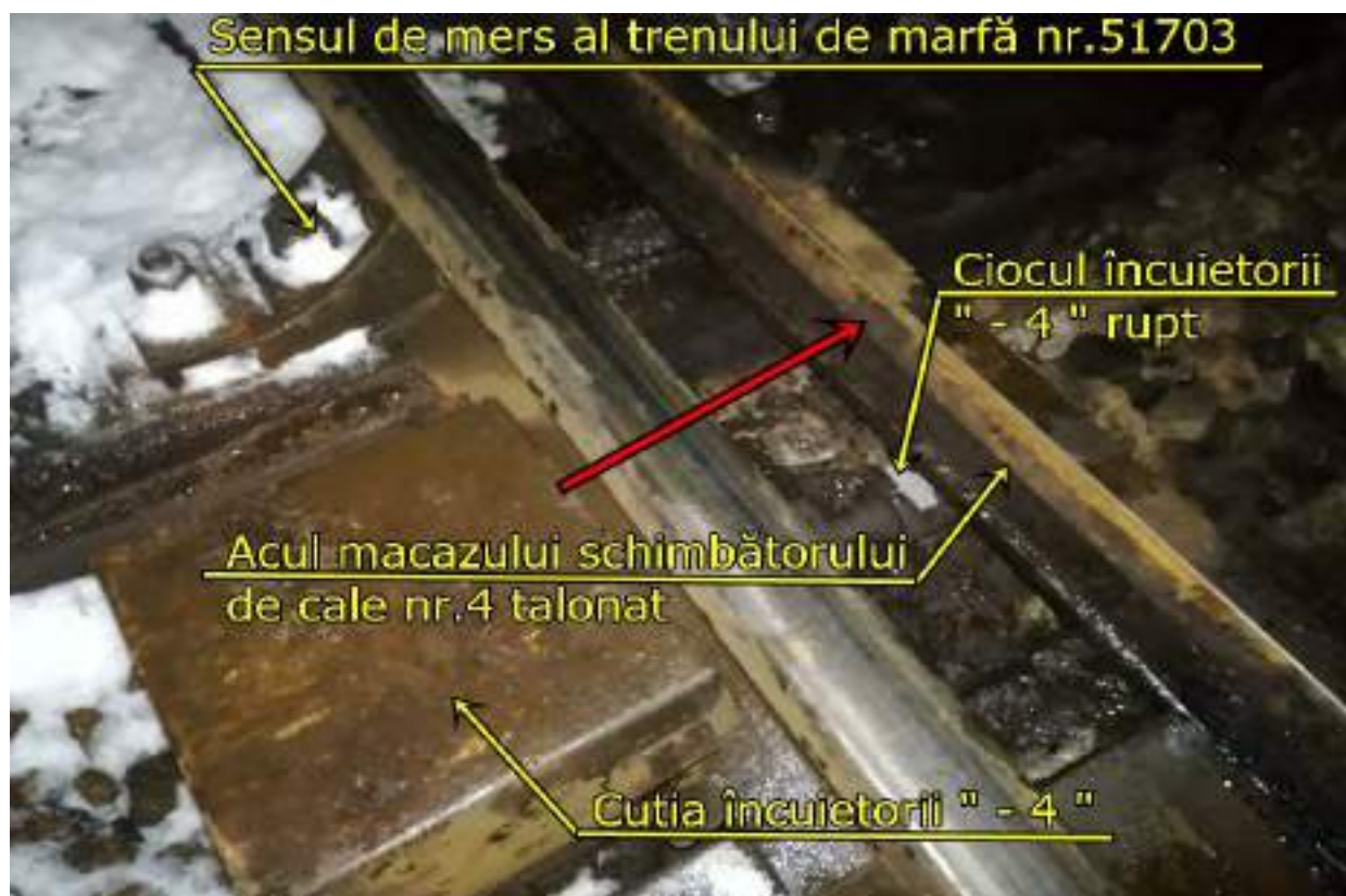
Fig.6 Macazul schimbătorului de cale nr.4 – talonat
