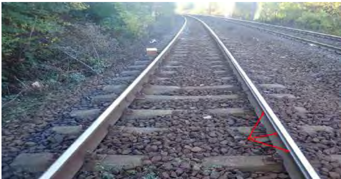
foto 9: uzuri ale șinei de pe firul exterior al căii
