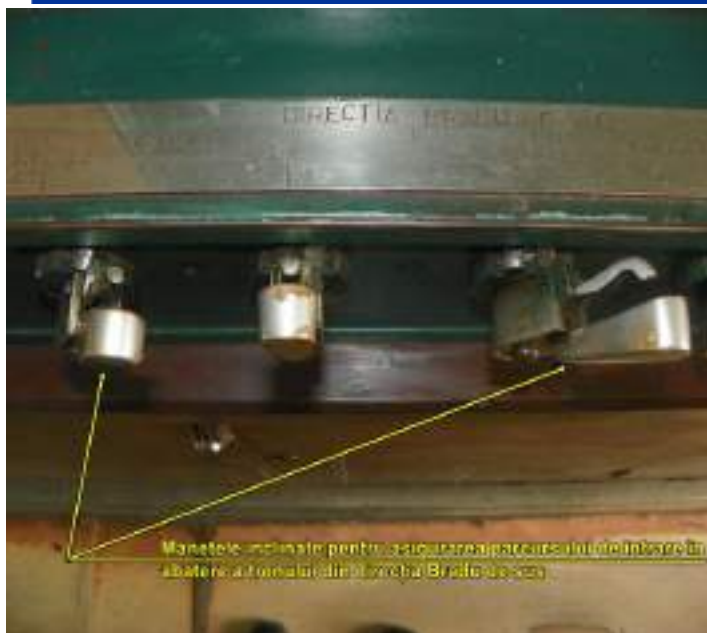
Fig. 7 Cutia mecanică a blocului SBW din biroul de mișcare
