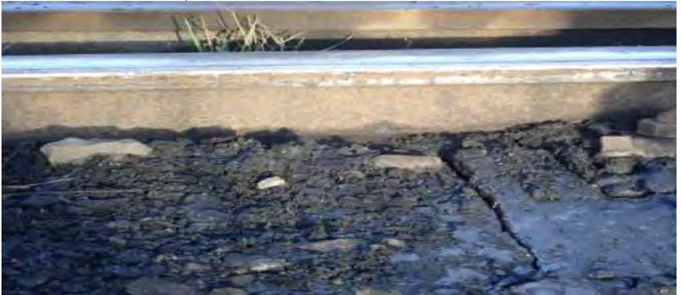
foto nr. 6: urme de frecare a roții din partea stângă pe flancul activ al ciupercii șinei, după punctul 0'
