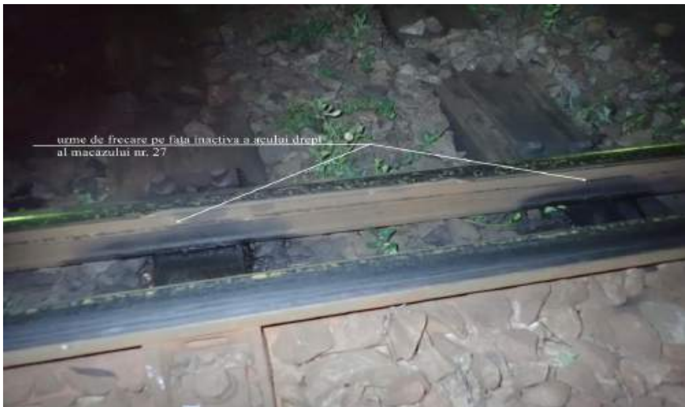
foto 8: urmele create de buza bandajului pe acul drept în urma talonării macazului
