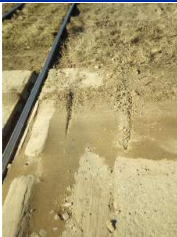
Foto nr.6 – Urme de lovituri în pasajul trecerii la nivel cu calea ferată din cap.X din hm Cacica, de la km. 20 +686
