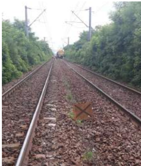
Fig. 3 Paleta cu fața galbenă și cu benzi negre în diagonală pentru restricția de viteză de la km 76+650 la km 76+550.
