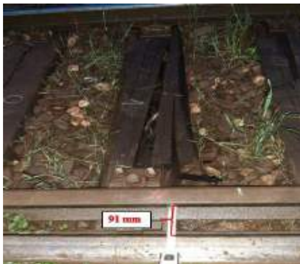
Foto. nr.6 în dreptul traversei T 1 valoarea măsurată a intervalului liber dintre fața laterală vecine ale ciupercii șinei de la firul interior al căii și contrașină
