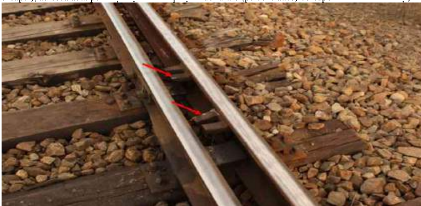
foto nr.7 : zonele de lovire și escaladare a proțapilor de către roțile deraiate
