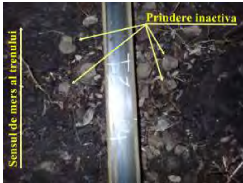
Foto nr.5 – prinderea placă – traversă inactivă
