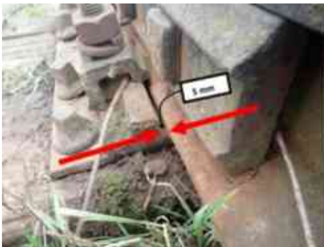
Foto. nr. 4 - Traversa 0 și 1. Între talpa șinei de la firul exterior al curbei (șina din partea stângă a sensului de mers al trenului) și rebordul plăcii metalice pod, exista un spațiu liber de 5 mm.
