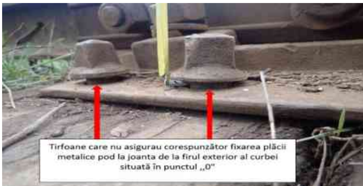
Foto. nr.6 - Traversa 0 și 1. Starea necorespunzătoare a prinderii plăcii metalice pod de la firul exterior
