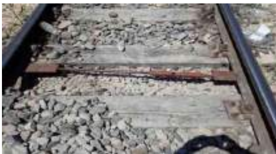
Foto nr.10 Tirant ce urmează a se monta la punctul 0 pentru asigurarea ecartamentului
