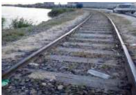
Foto nr. 8 Prisma de balast colmatată cu material pulverulent
