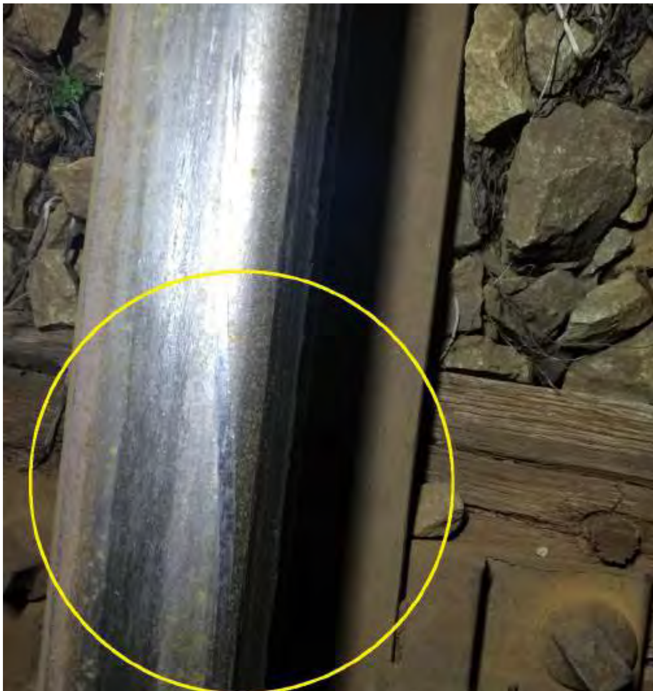
Foto nr.6 - Urma de escaladare a buzei bandajului roții din stânga de la osia 6
