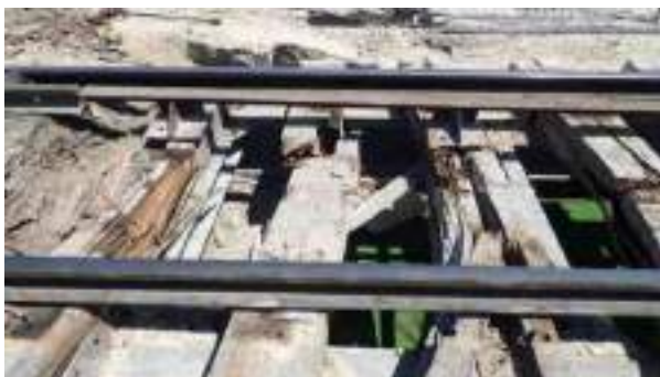
Foto nr.9 Traversele de pod distruse
