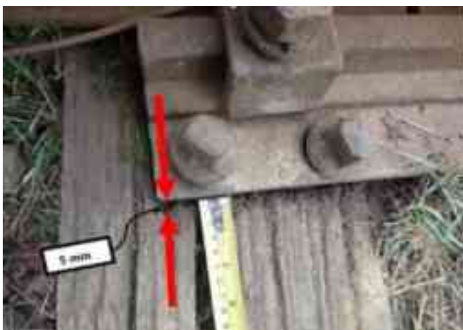
Foto. nr. 5 - Traversa 0 și 1. Urmă de deplasare a plăci pod, pe direcție radială, în sensul creșterii ecartamentului, care avea lungimea de 5 mm.
