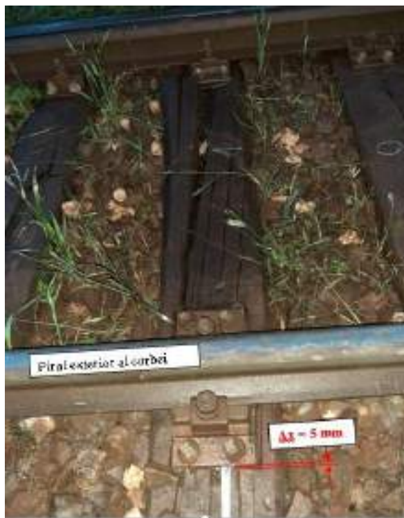
Foto. nr.5 T_1 valoarea cu care se deplasa placa metalică de la exteriorul curbei pe direcție radială în sensul creșterii ecartamentului \Delta x = 5 mm
