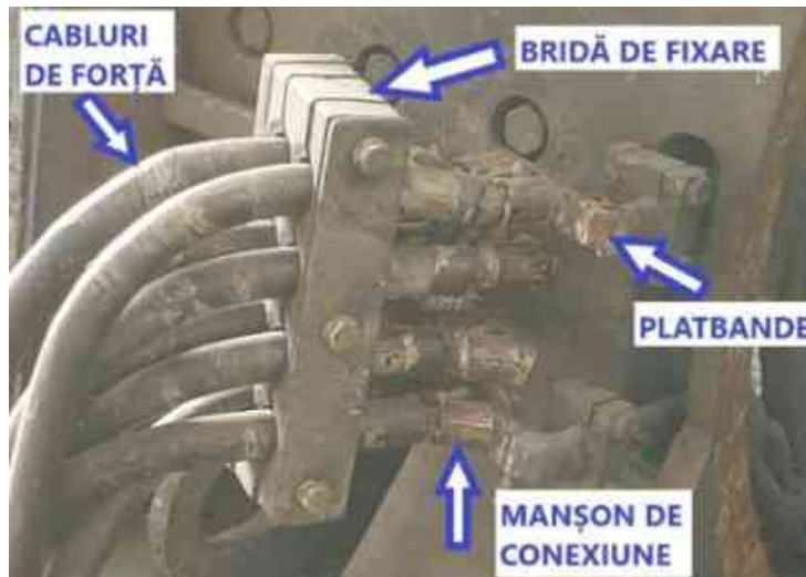
Imaginea. nr.4 - zona conexiunilor la MET – (exemplu fără matisajul pe manșoane)
