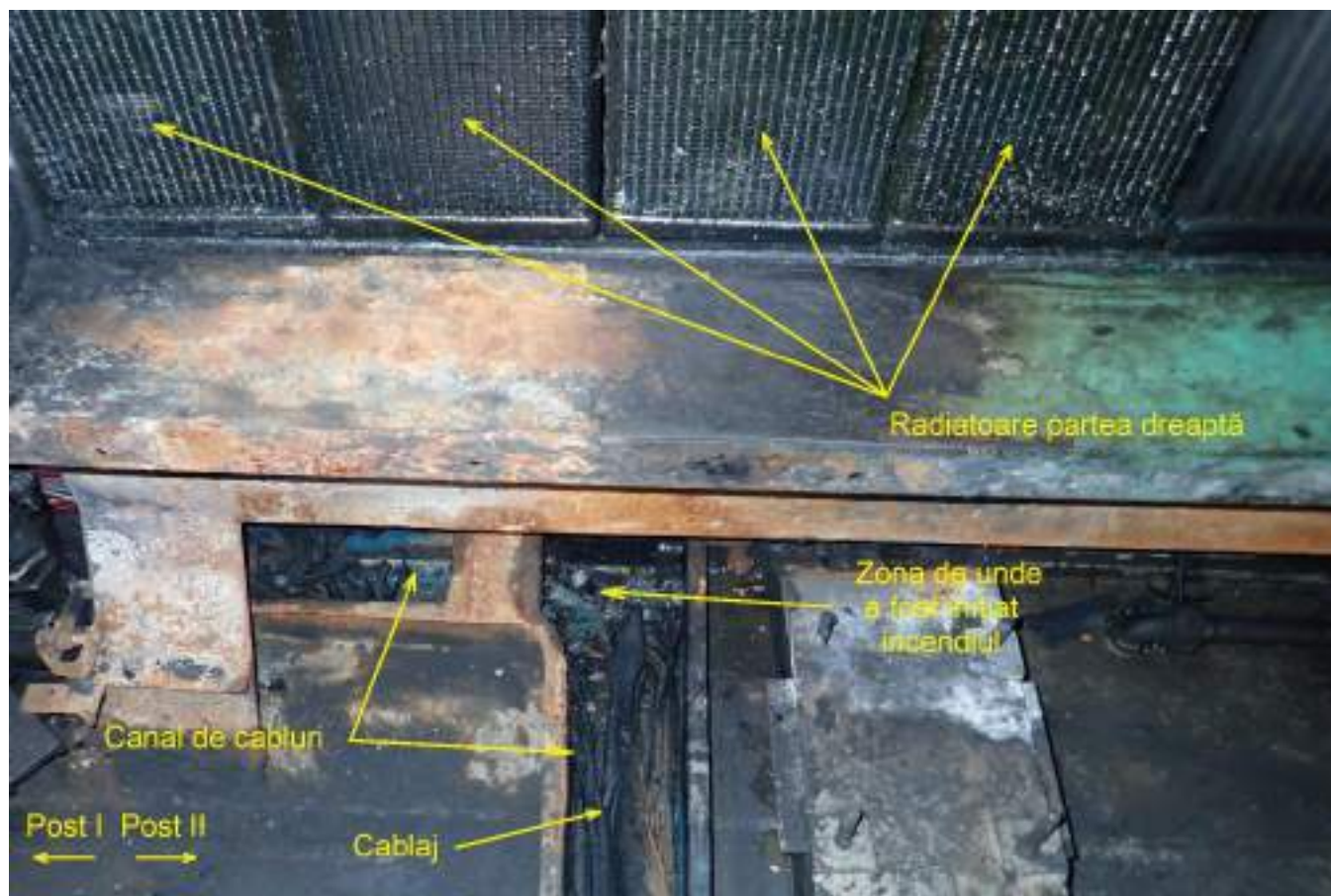
Foto nr.1 - Locul declanșării incendiului
