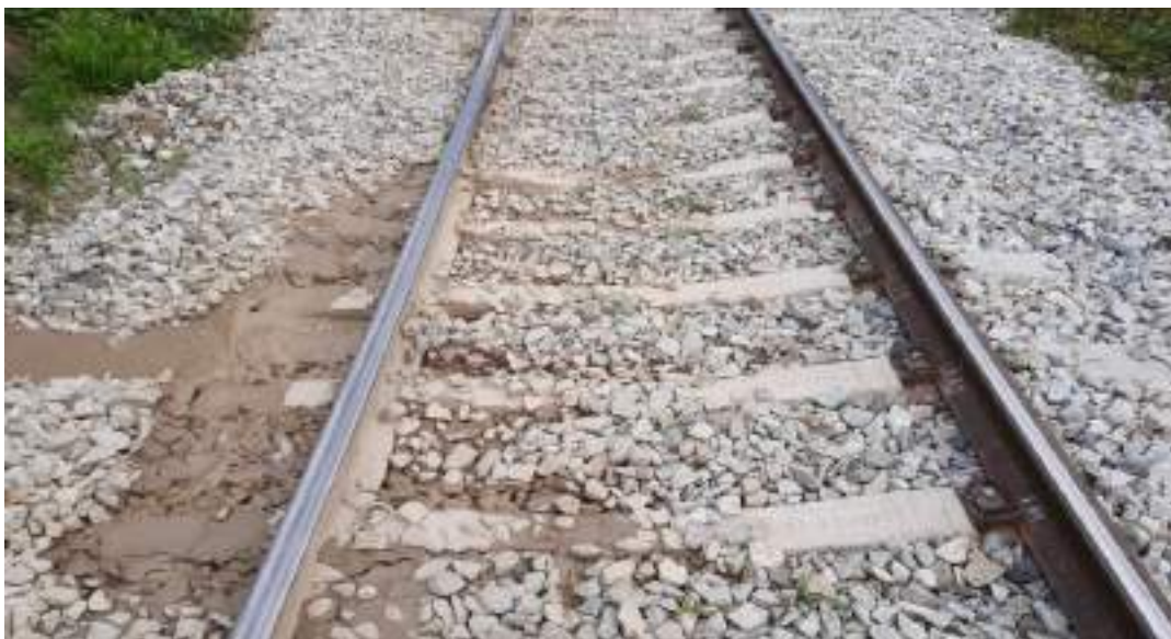
Imaginea nr.11 - prisma de piatră spartă în zona accidentului
