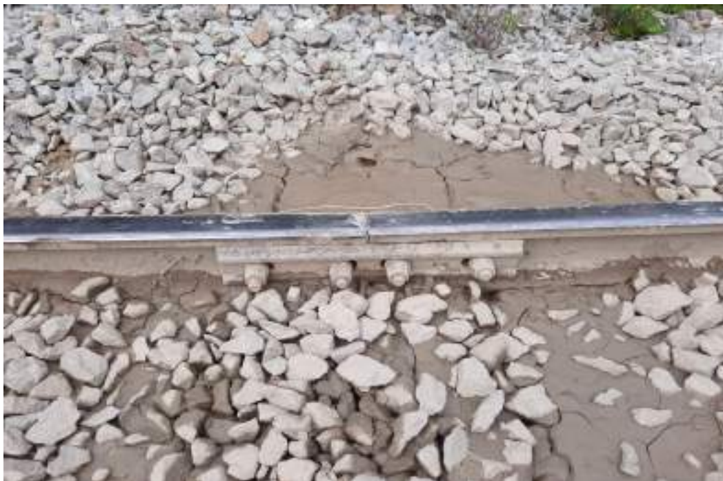
Imaginea nr.10 – joanta mecanică de la km 37+659 de pe firul interior al curbei
