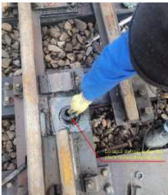
Foto nr. 10 Locașul special inelar din placa metalică suport rupt
