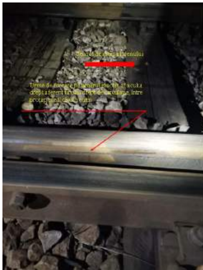
Foto nr. 7 Urme de frecare pe umărul inactiv al acului drept între proțapi și călcâiul acului
