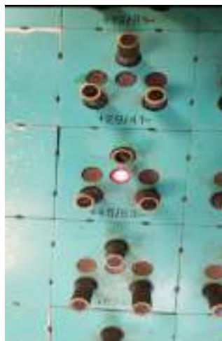
Foto nr.13 Macazul nr.45/53 fără control pe luminoschemă
