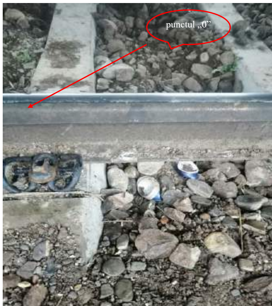
Foto nr. 1 - Prima urmă de escaladare a roții atacante a primei osii a locomotivei EA 038 a fost identificată pe șina din dreapta, sens de mers, la km. 0+843, denumit punctul „0”.
