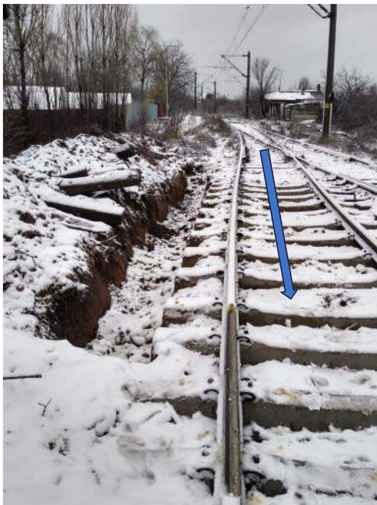
Foto nr.3 –șanțul aflat înainte de punctul 0.
