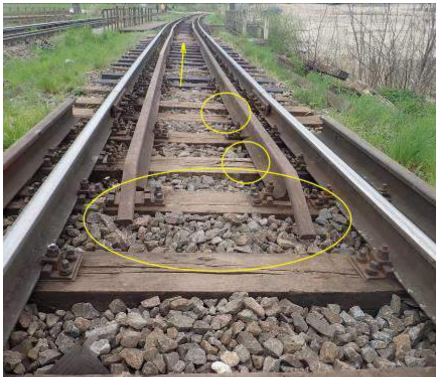
Foto nr.44 – contrașina montată necorespunzător după lucrările de reparații ca urmare a accidentului
