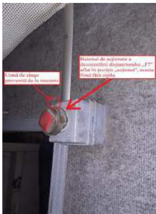
Foto nr.2 - butonul de acţiune a deconectării disjuncturului „F7”
