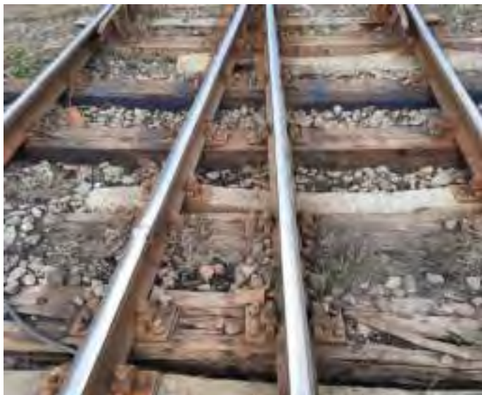
Imaginea nr.13 - zona șinelor de legătură și a inimii de încrucișare a schimbătorului de cale nr.47, la data de 21.02.2024
