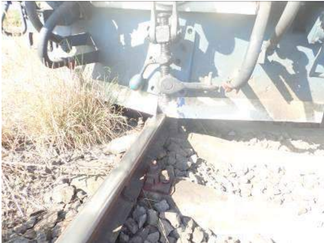
Foto nr.5 – poziția plugului locomotivei deraiate
