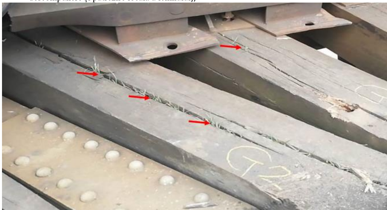
foto nr.9: vegetație crescută în cuprinsul traverselor speciale de pe pasajul inferior
