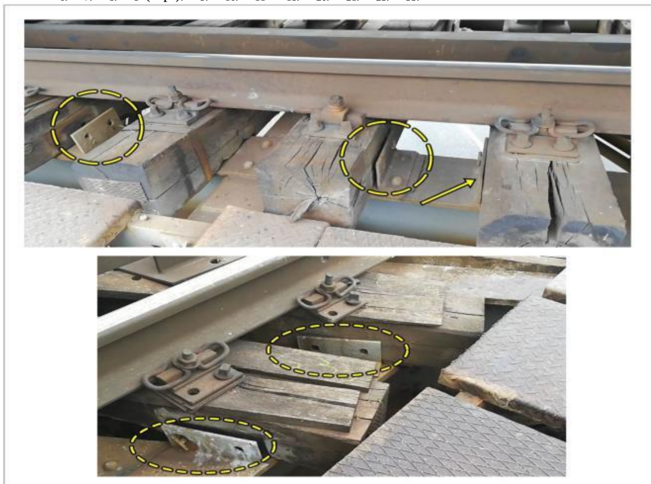
foto nr.10: lipsa șuruburilor orizontale de prindere a traverse de elementul metalic al podului
