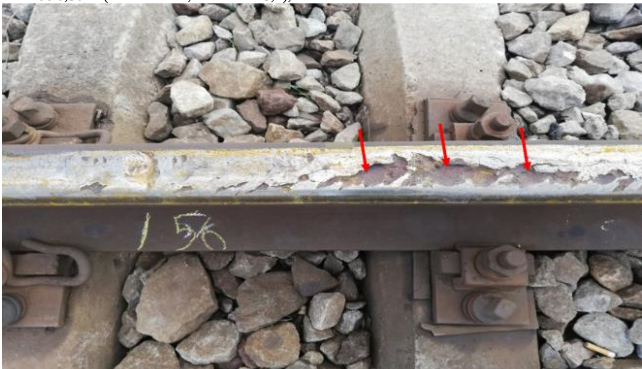
foto nr.4: uzuri (exfolieri) ale șinei pe firul exterior al curbei
