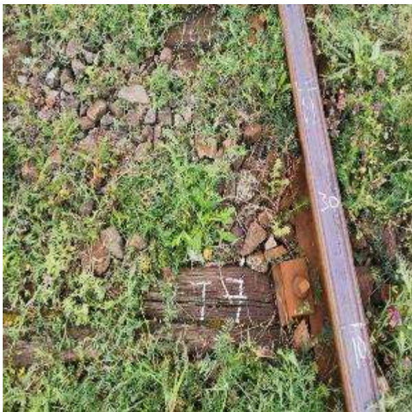
Foto. nr.11 – Starea tehnică a traversei T 7
