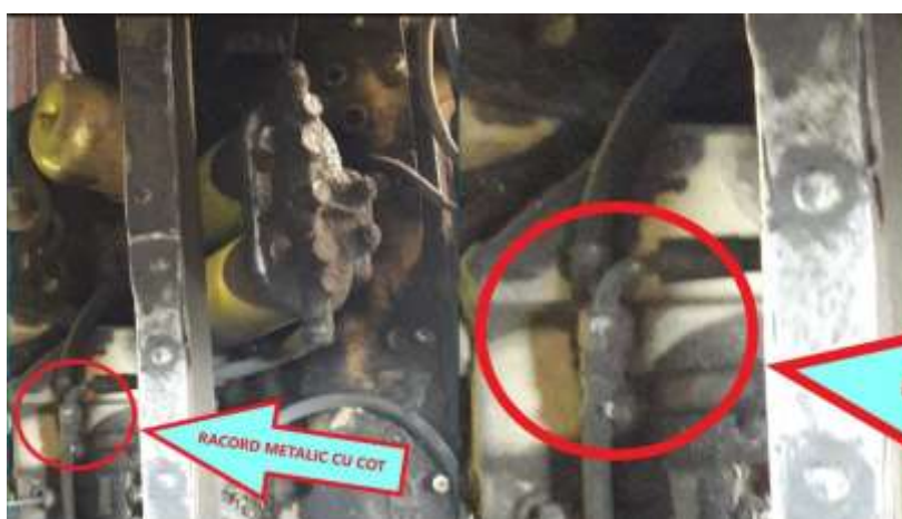
Imaginea nr.7 – cotul de 90 0 de la racordul metalic al furtunului de intrare (desen de la fabricantul Tedom)
