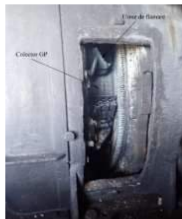
Foto nr.2 – Generatorul principal
