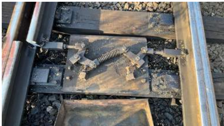
Foto nr.16 – Starea dispozitivului ajutător de manevrare cu arc Fig. nr.4 – Figura din IL 302 4.4
