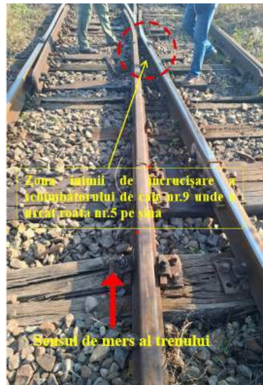
Foto nr.7 – Zona inimii schimbătorului de cale nr.9
