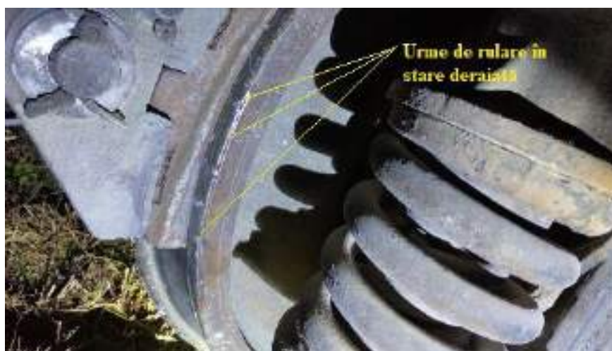
Foto nr.3 - Urme de rulare în stare deraiată
