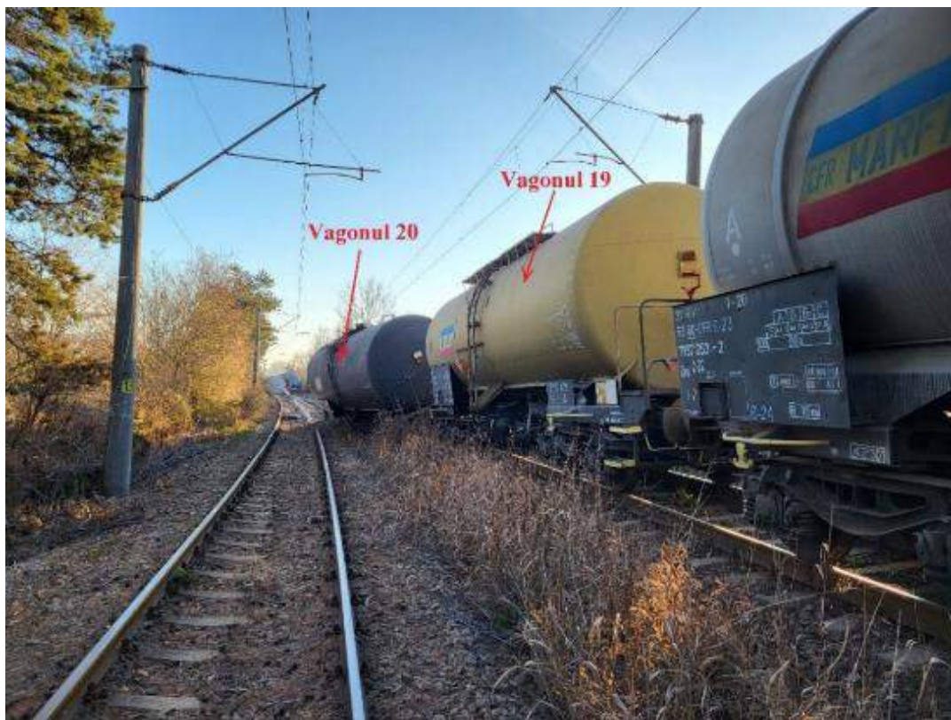
Foto nr.2 – poziția vagoanelor nr.19 și nr.20 după deraiere
