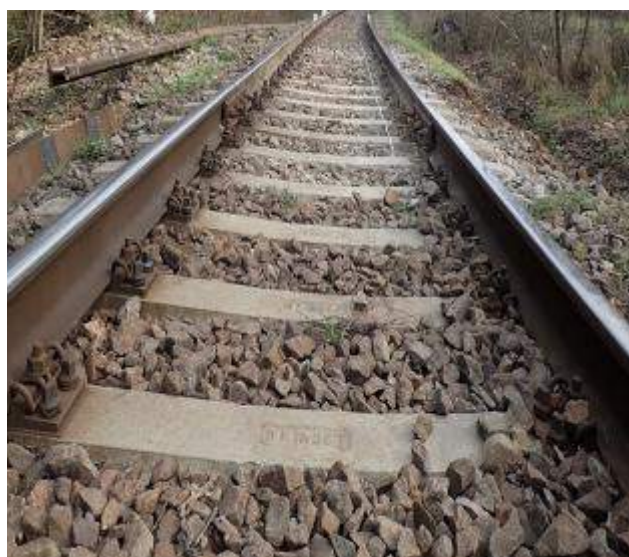
Foto nr.15 – Prindere completă și activă
