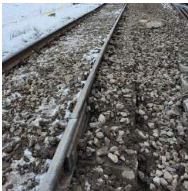
Foto nr.21 – Firul I deripat în urma accidentului
