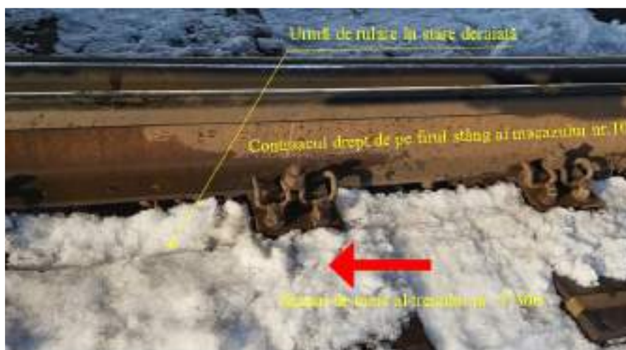
Foto nr.15 – Urme de rulare în stare deraiată la 10 cm de contraacul drept de pe firul stâng
