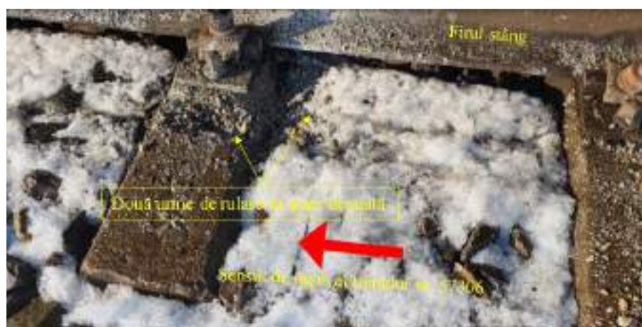
Foto nr.17 – Două urme de rulare în stare deraiată pe aliniamentul dintre schimbătoarele de cale nr.10 și nr.8
