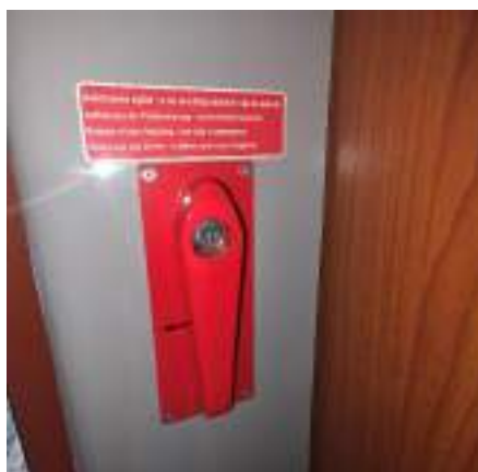
Foto nr.11 – dispozitiv de izolare a ușii
