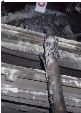
Foto nr.5 Burduful flexibil de legătură între canalul de ventilație și EMT nr.3
