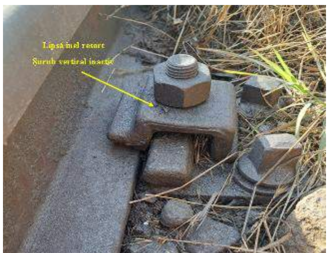
Foto nr.17 – Șurub vertical inactiv
