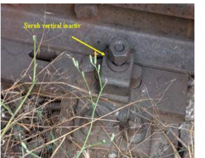
Foto nr.18 – Șurub vertical inactiv
