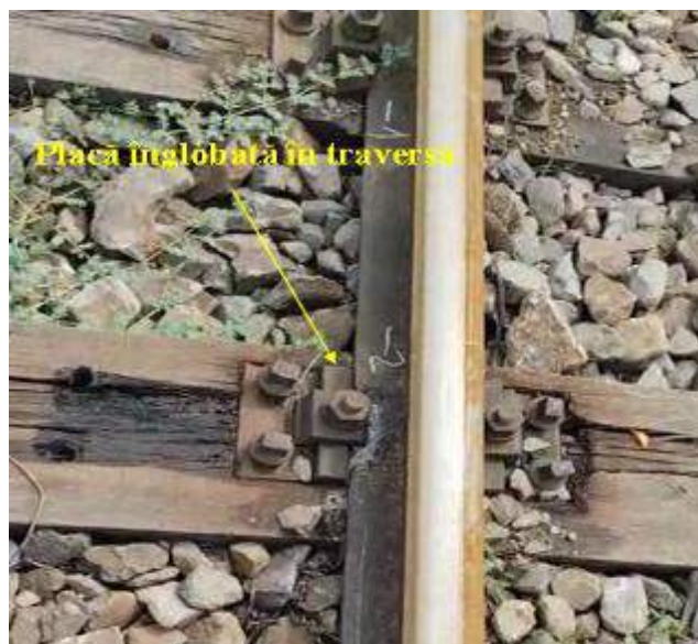
Foto.nr.4 – Traversă cu placa înglobată
