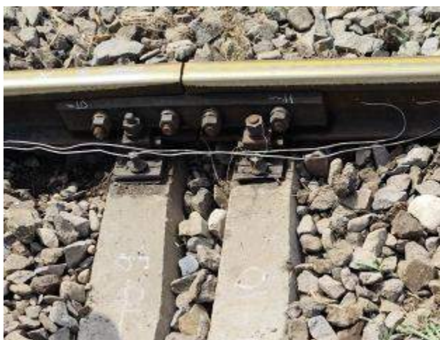
Foto nr.12 – Rosturile de dilatație
