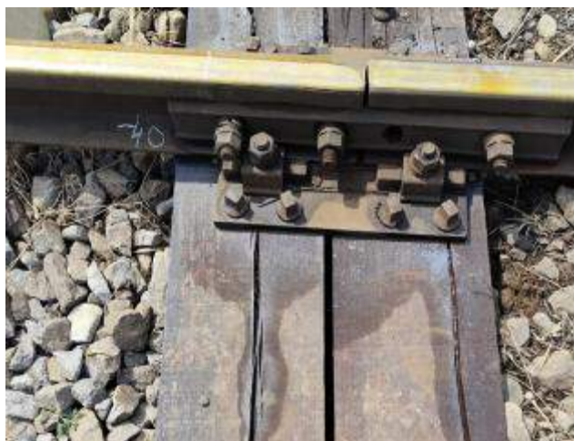
Foto nr.11 – Rosturile de dilatație
