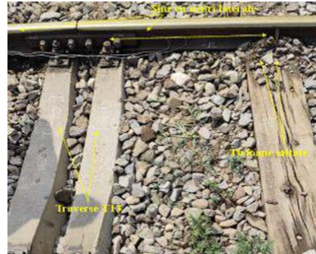
Foto.nr.8 – Traverse de beton T13
