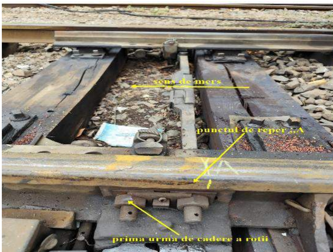
Foto nr.15 – punctul de reper „A” – punctul de cădere al osiei nr.1 în exteriorul căii
