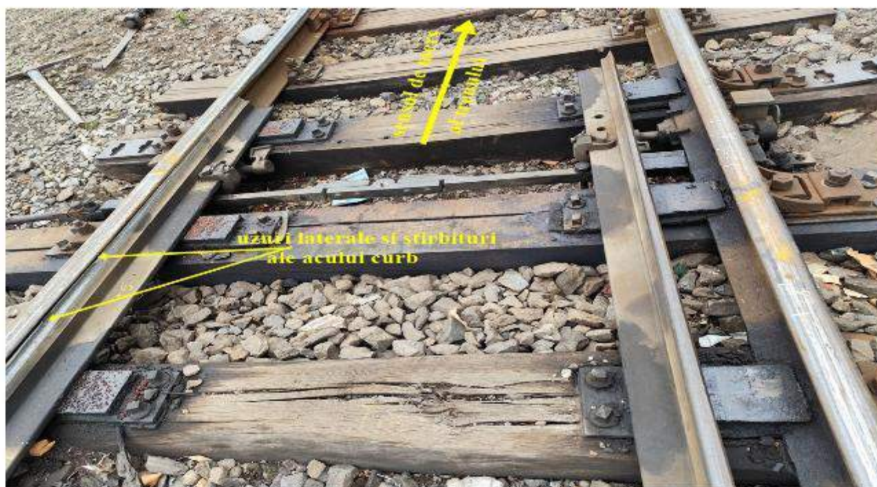
Foto nr.26 – uzură laterală și știrbituri pe acul curb
