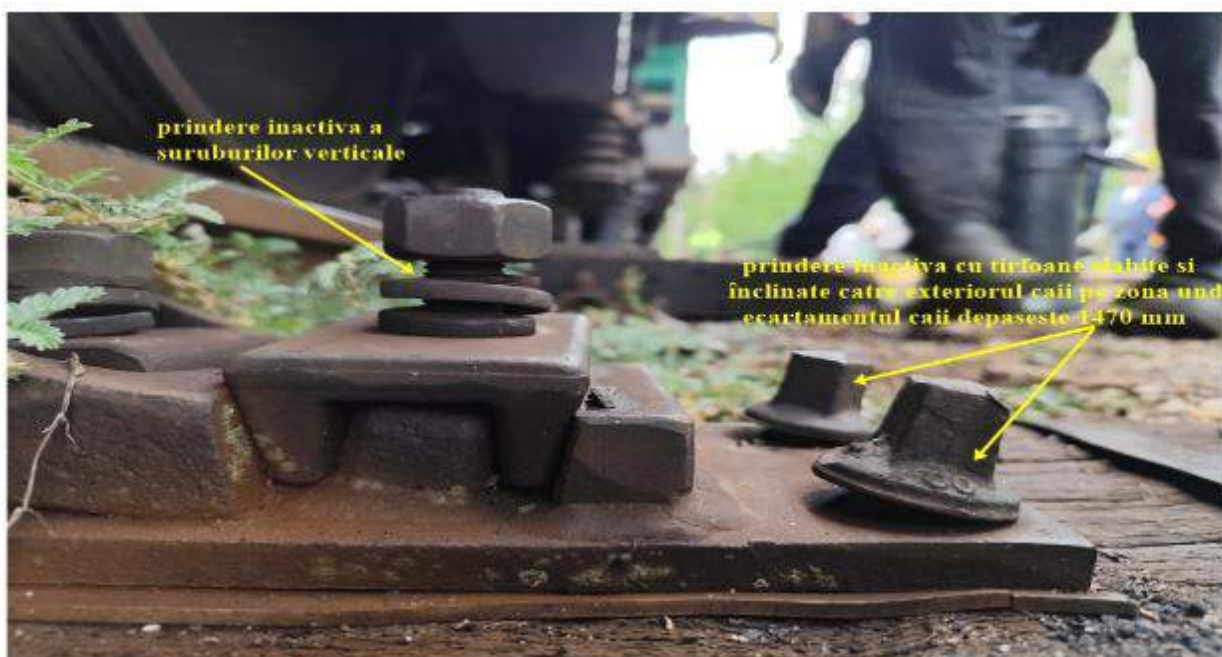
Foto nr.21 – prindere placă metalică – traversă inactivă
