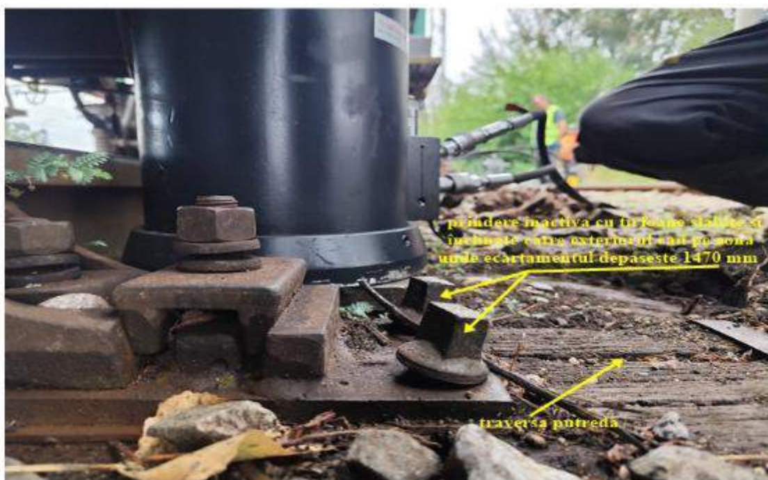
Foto nr.22 – prindere inactivă placă metalică – traversă
