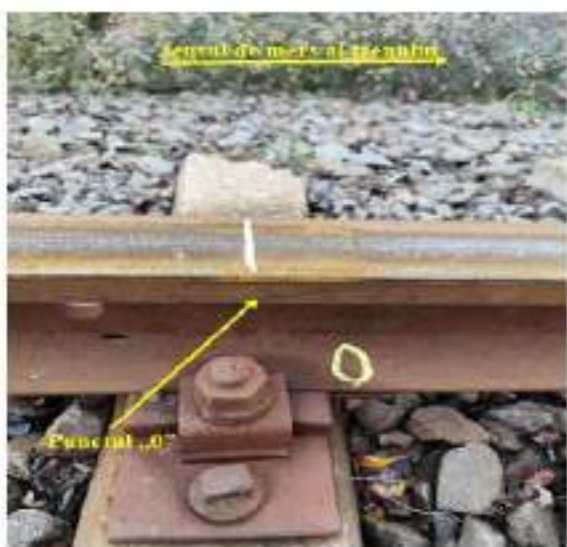
Foto nr.6: Punctul „0”-prima urmă de escaladare a feței active a firului din partea stângă a căii
