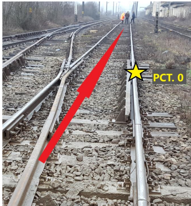
Imaginea 3- porțiunea de linie parcursă de trenul deraiat
