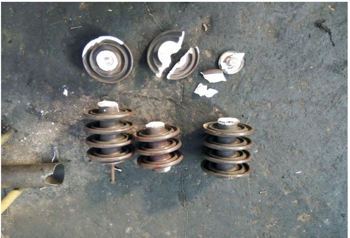
Foto nr.7 - Izolatori susținere pantograf secționati
