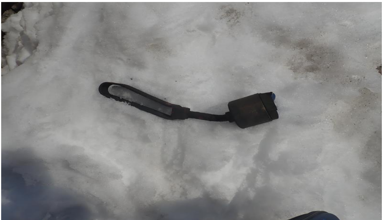
Foto nr.5 - Deformarea barei încastrate în izolatorul de tracțiune secționat
