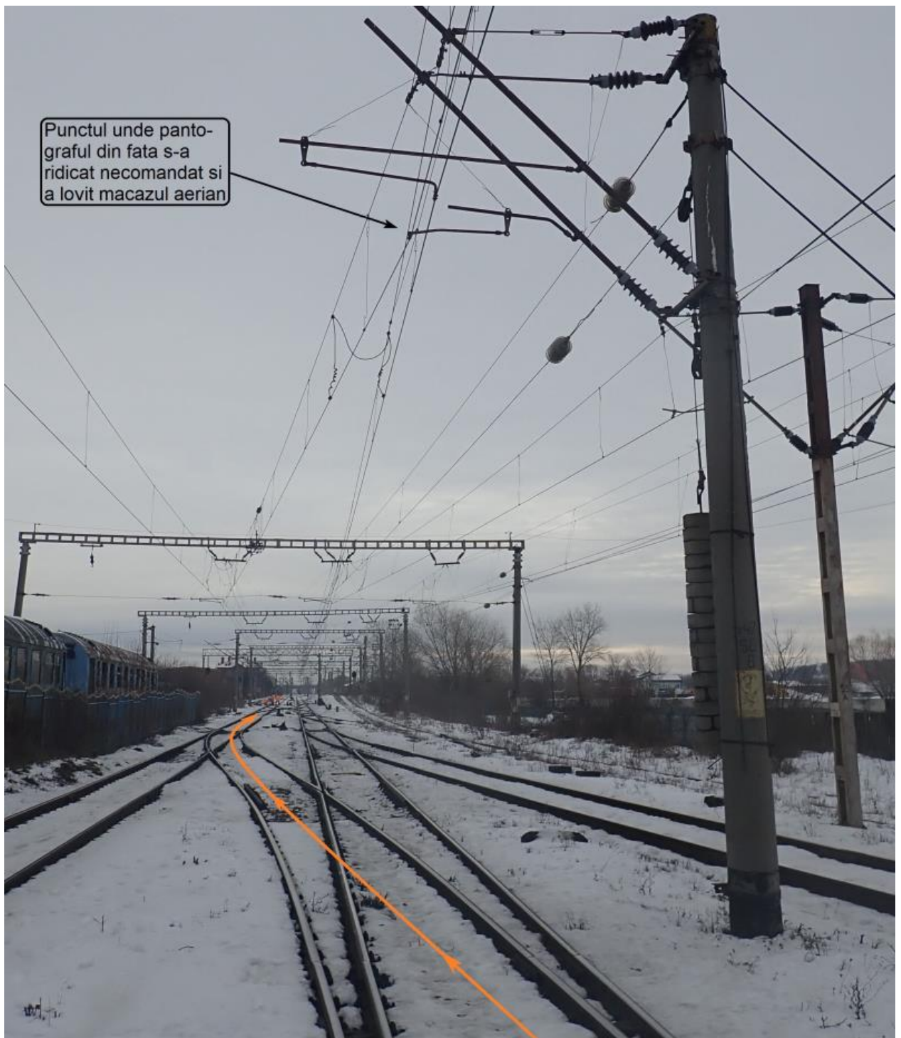
Foto nr.1 - Traseul de intrare a trenului de calatori R nr.5454, de pe firul II Suceava Nord – Suceava, în abateră la linia nr.2 din stația Suceava, pe diagonala 20/28
