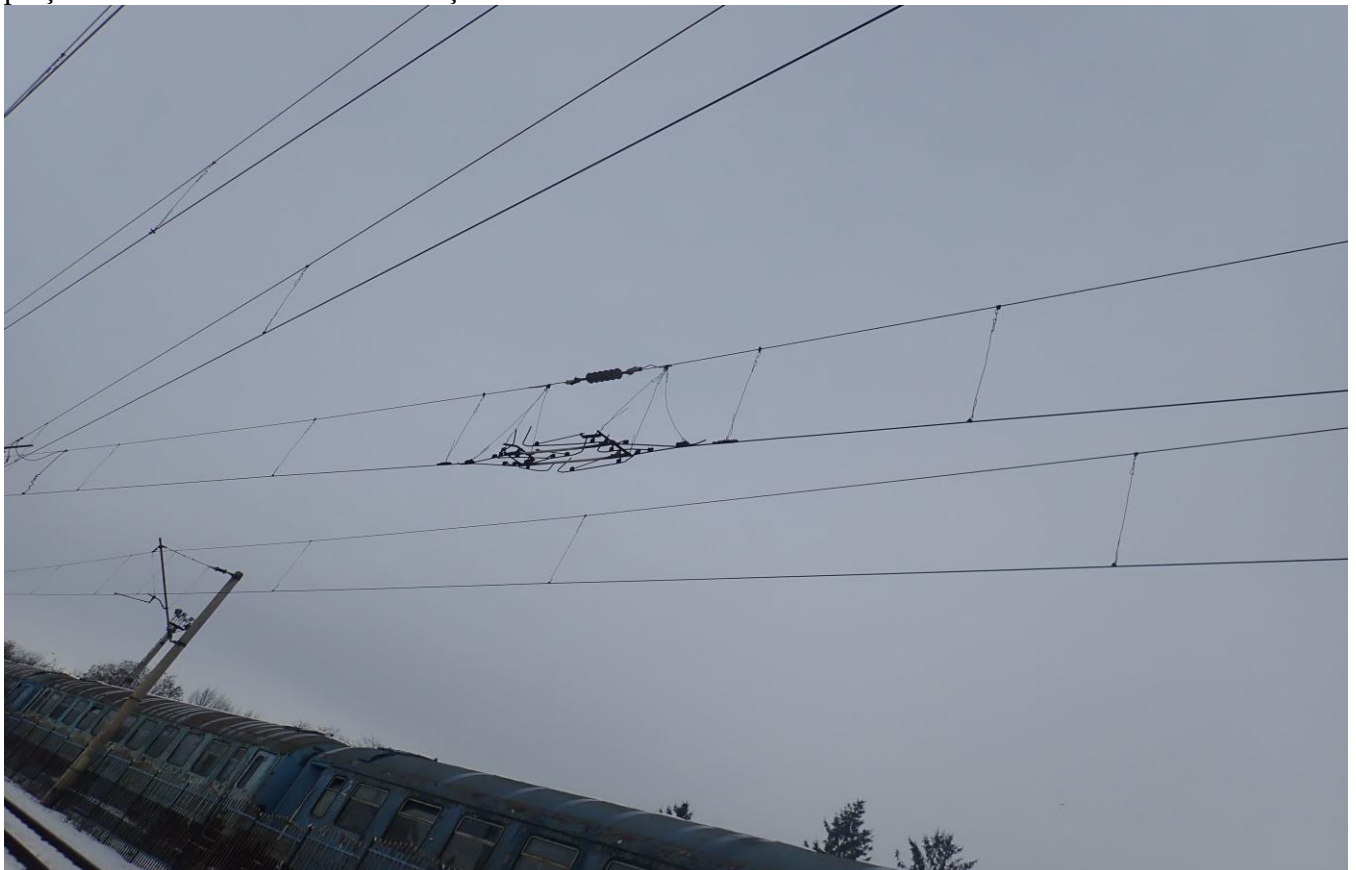
Foto nr.16 – Zona aeriană a saniei glisieră a izolatorului de secționare parțială a liniilor de contact din stație
