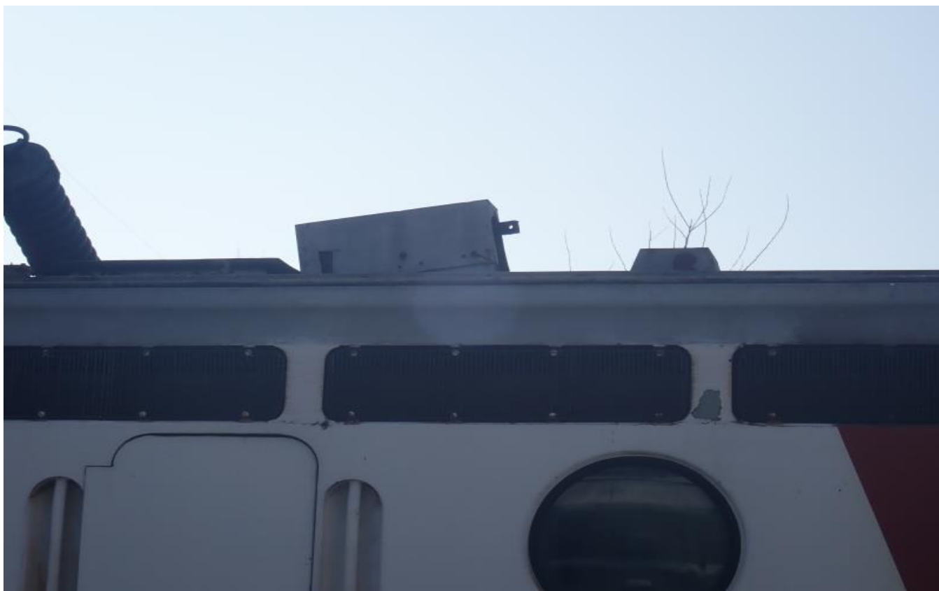
Foto nr.3 - Acoperișul locomotivei EC126 după avarierea pantografelor
