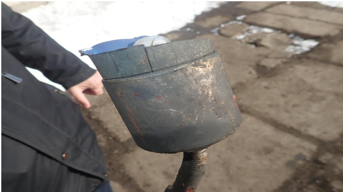
Foto nr.14 – Fisuri vechi în corpul izolatorului de tracțiune
