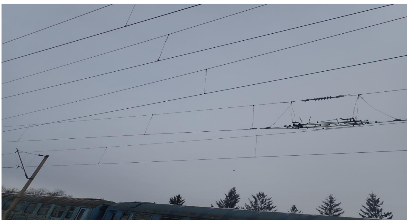
Foto nr.9 - Zona aeriană a diagonalei 20/28 unde a avut loc desprinderea necomandată a pantografului inactiv
