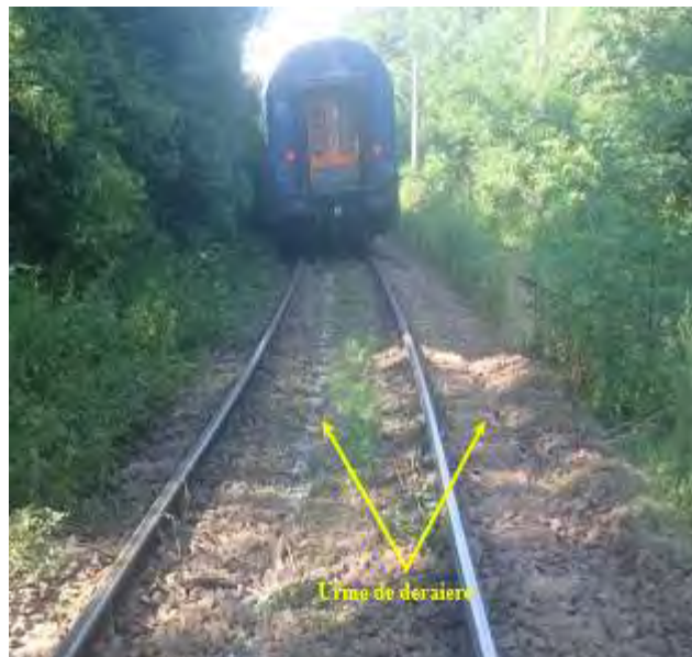
Foto nr.11- Urme de deraiere
