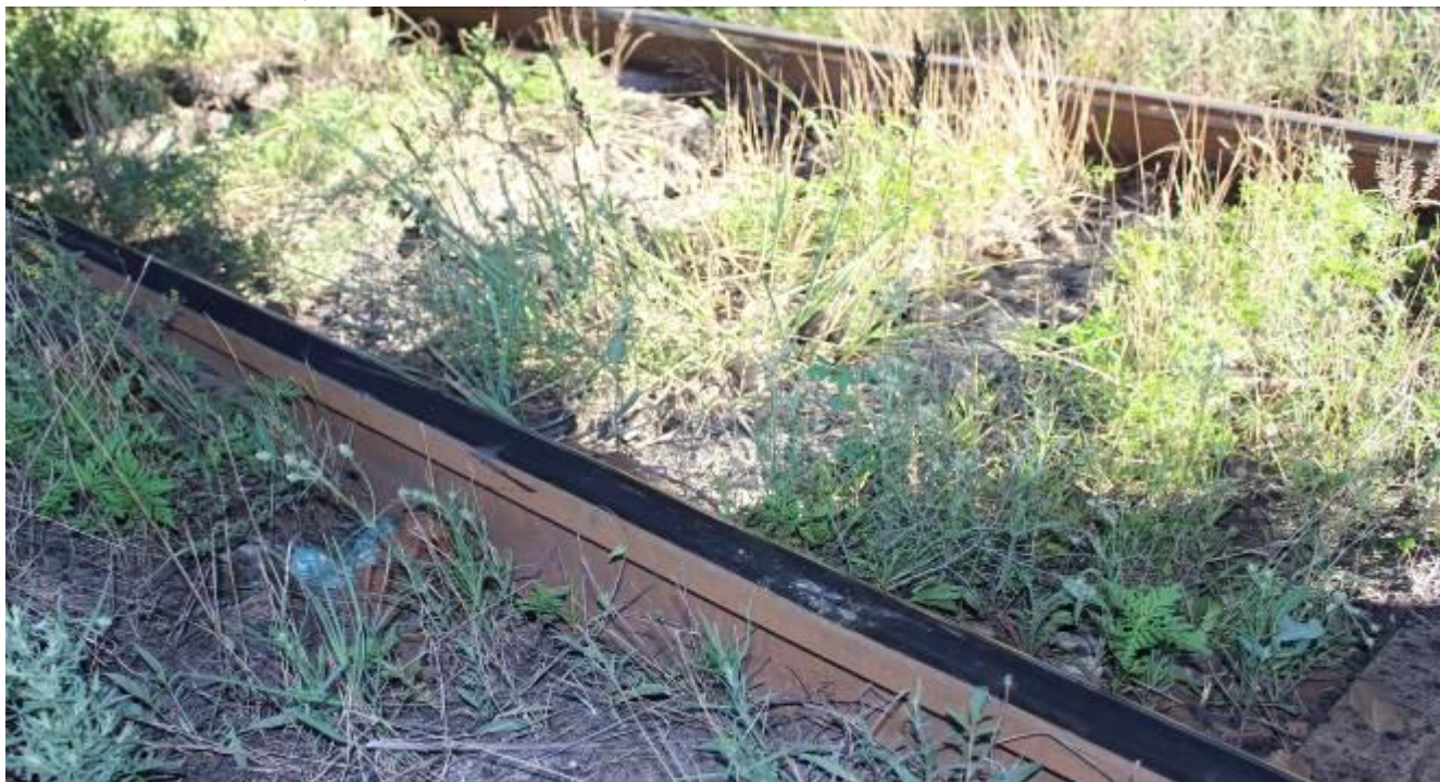
foto 6 – starea prisme de piatră spartă pe zona producerii accidentului
