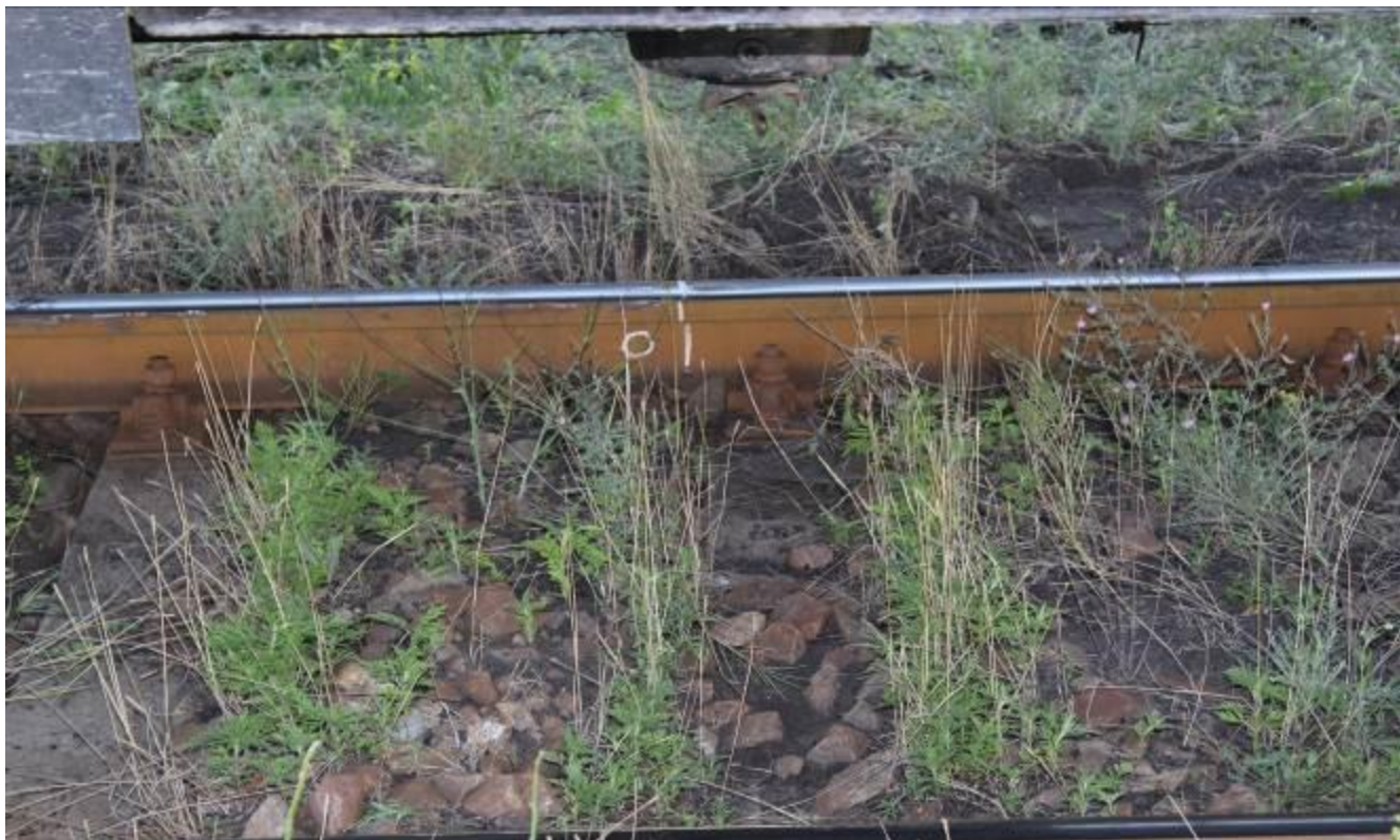
foto 27: urma buzelor bandajelor roților dreapta la părăsirea ciupercii șinei în zona punctului 0
