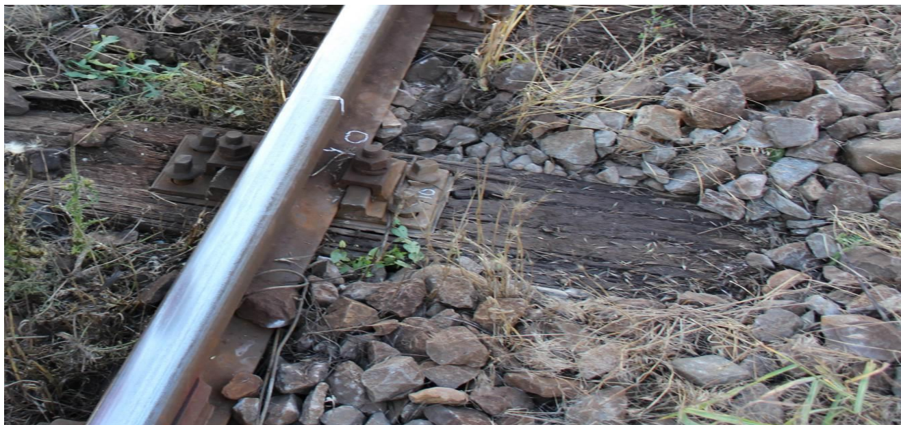
foto 15: starea traversei T 0 pe capătul drept, în sensul de mers al trenului
