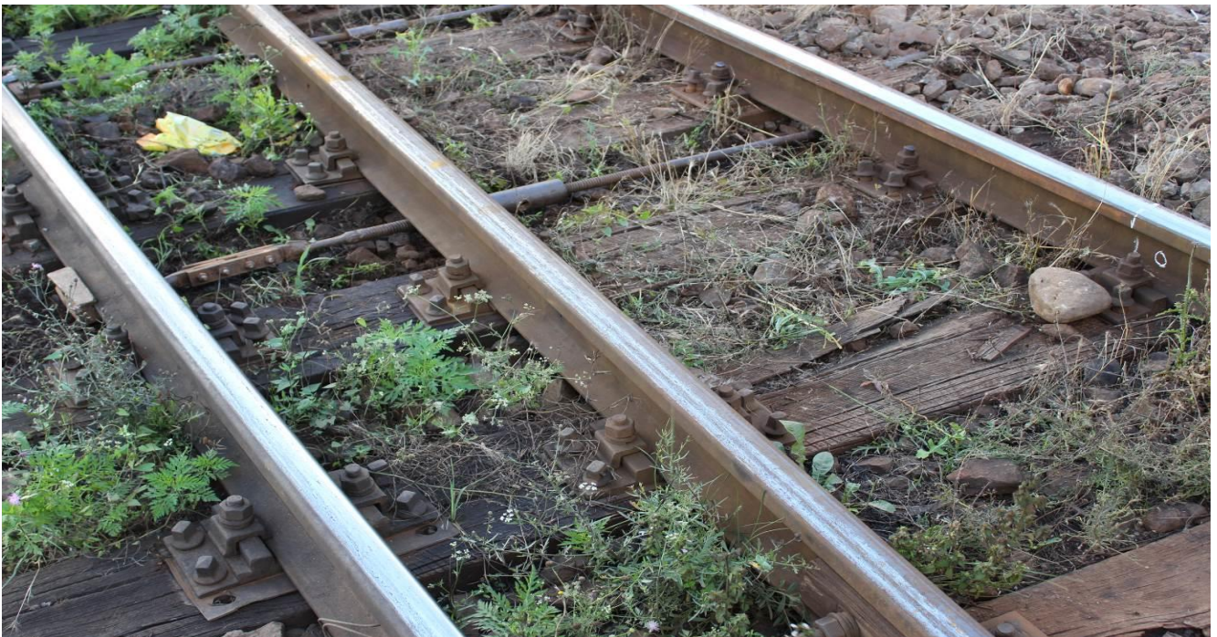
foto 13 : dispozitivele de ajustare a ecartamentului
