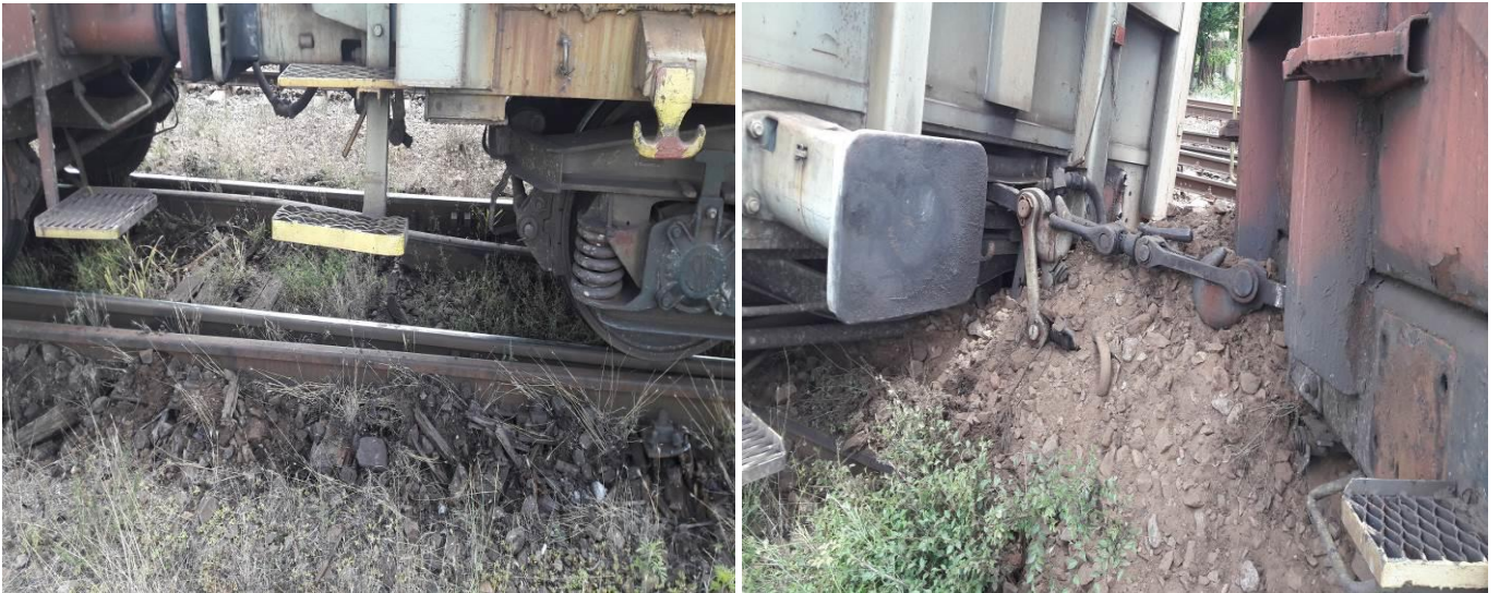
foto 7-10 : afectarea suprastructurii feroviare
