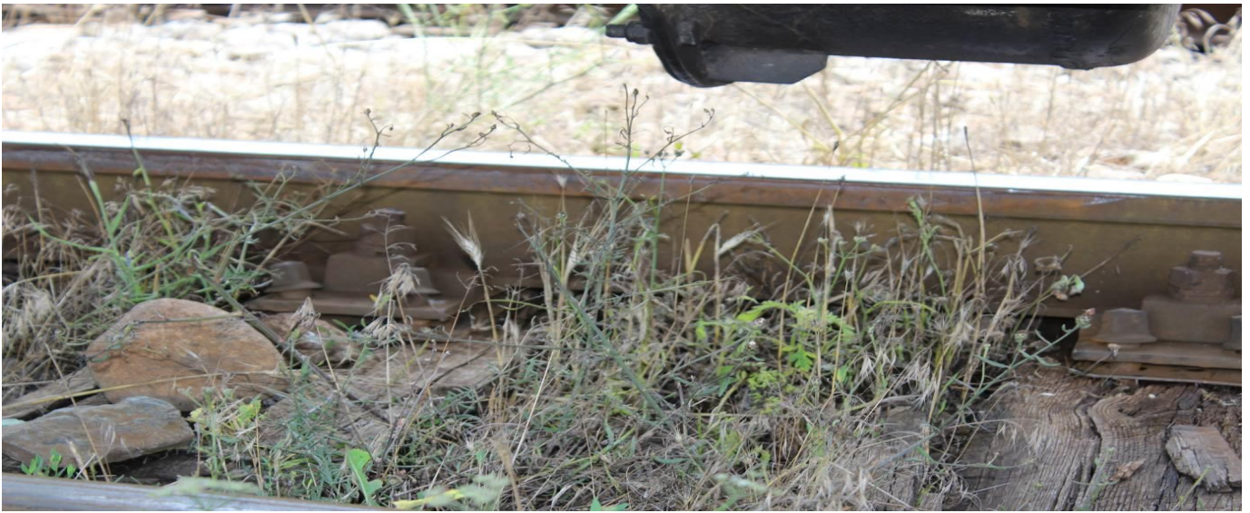
foto 16: urme specifice de deraiere pe flancul activ al ciupercii șinei, în zona punctului 0
