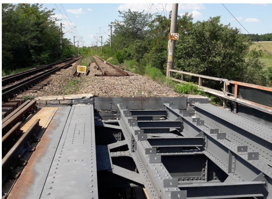
Foto nr. 8- Terasamentul din spatele culeei Banu Mărăcine (culeea C2) șine, contrașine interioare și traverse sunt scoase din cale
