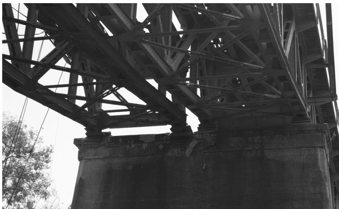
foto nr.14- rezemarea pe pila 1 a tablierului II de pe firul I (pericol de cădere a acestui tablier)
