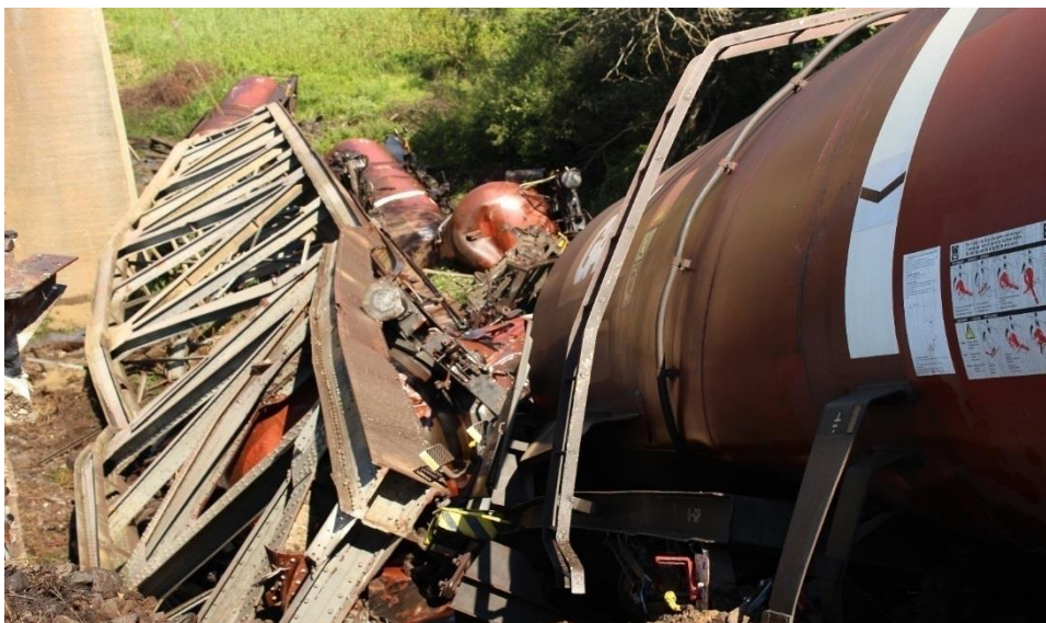
foto 12- tablierul I după prăbușire
