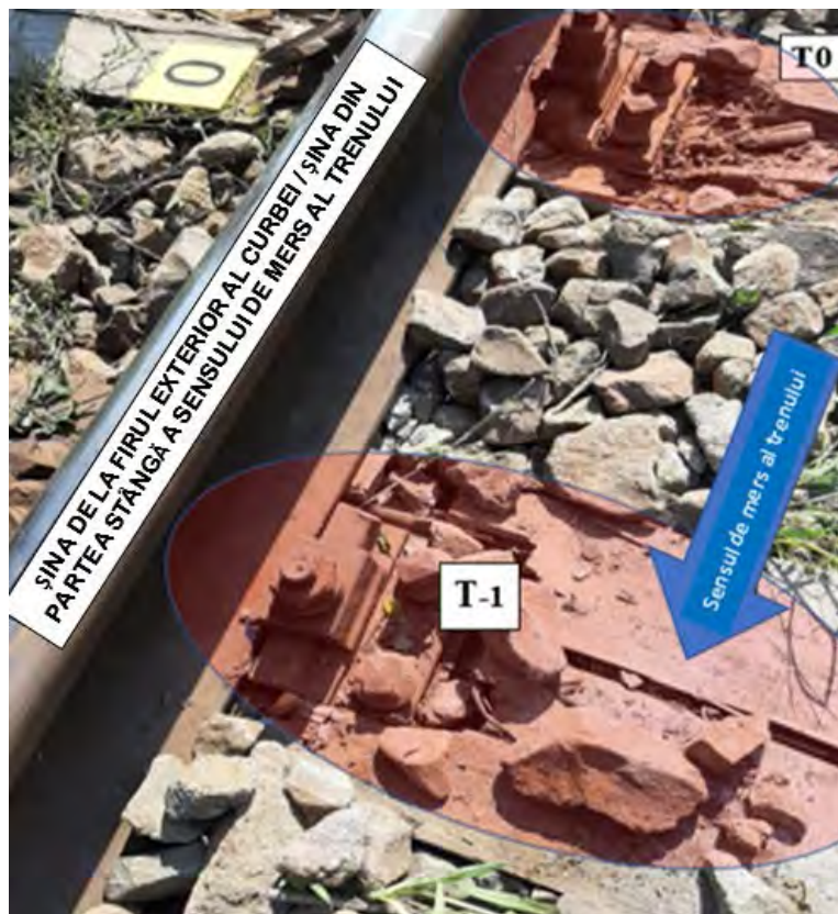
Fotografia nr.21 Traversale T 0 și T-1: detaliu cu zona prinderilor de la firul exterior (vedere din spre exteriorul căii)
