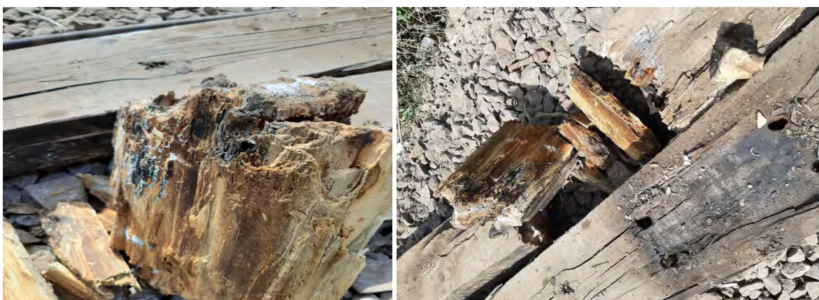
Fotografia nr.23 și 24 - zone cu putregai situate la interiorul traverselor
