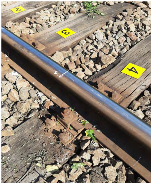
Fotografia nr.20 Traversa T3 – detaliu zona cu zona prinderilor de la firul exterior (vedere din spre exteriorul căii)
