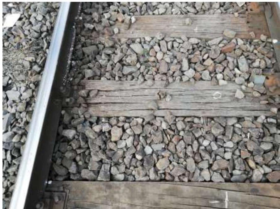
Foto. nr.3 - Prinderea șinei de traverse la traversele nr.-1, nr.0 și nr.1, pe firul interior al curbei
