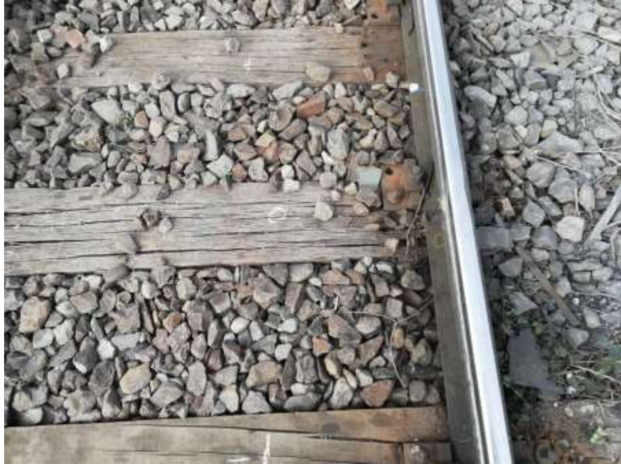
Foto. nr.2 – Prinderea șinei de traverse la traversele nr.-1, nr.0 și nr.1, pe firul exterior al curbei
