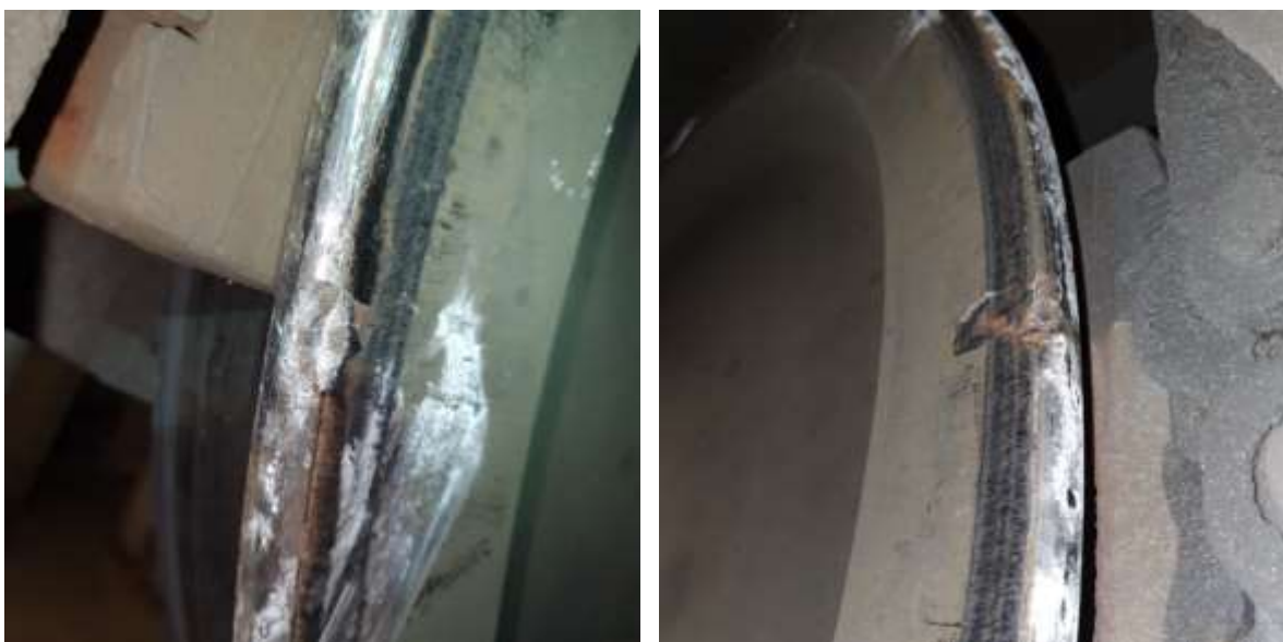
Foto nr.1 știrbituri pe buza roții din partea stângă a osiei nr.6 a locomotivei EA 2002
