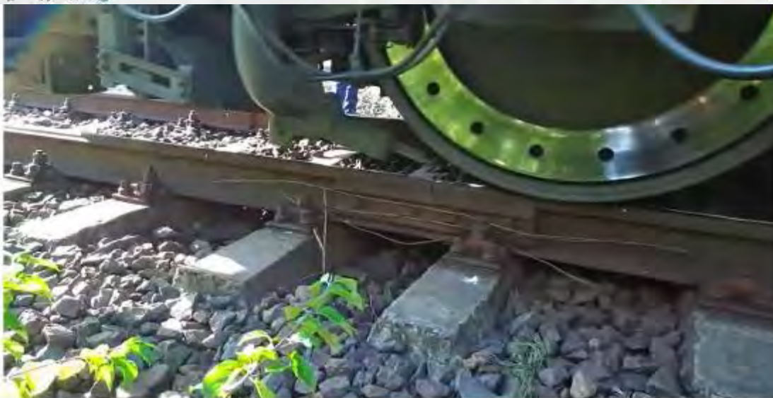
Video nr.1 Verificări dinamice privind stabilitatea în plan vertical a joantei situate în punctul „0” (km 492+680)
