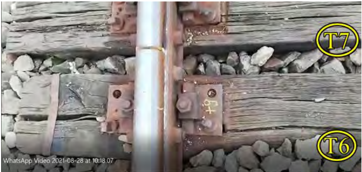
Foto. nr.17 – Prinderea șinei de traverse la traversele T6 și T7 pe firul interior al curbei
