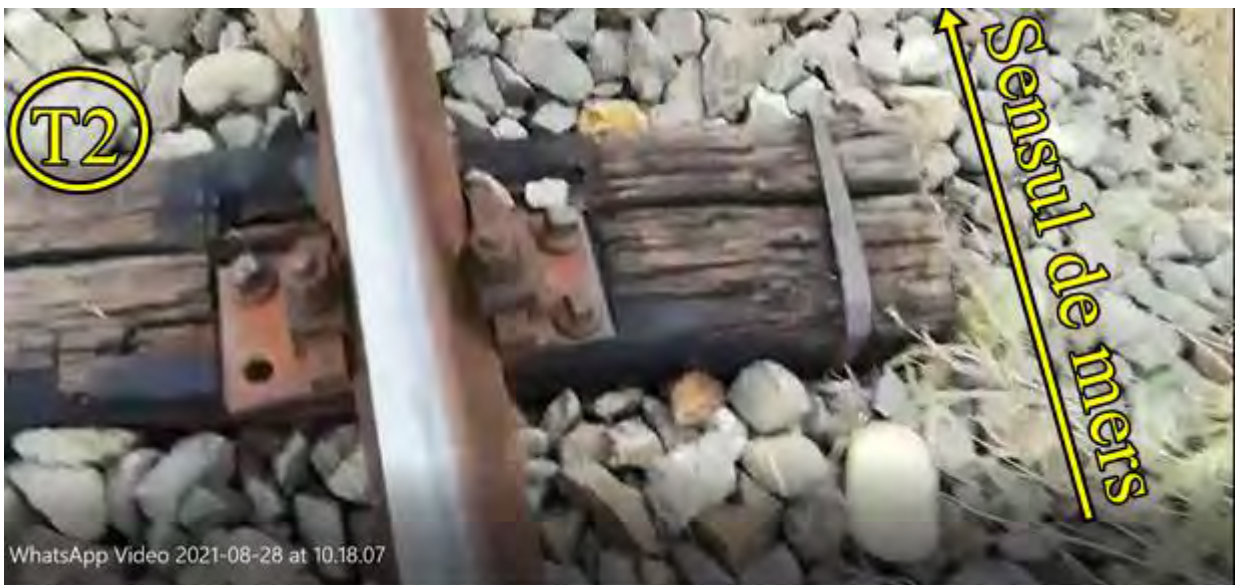
Foto. nr.14 – Prinderea șinei de traverse la traversa T2,pe firul exterior al curbei
