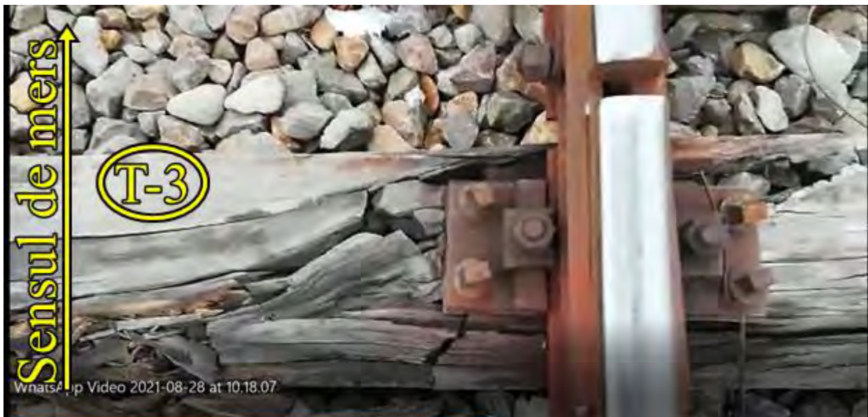
Foto. nr.7 – Prinderea șinei de traverse la traversa T-3,pe firul exterior al curbei
