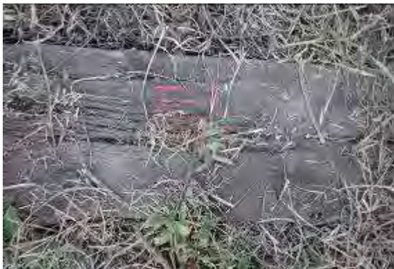
Foto nr.13- traversa „T-2”(zona centrală)
