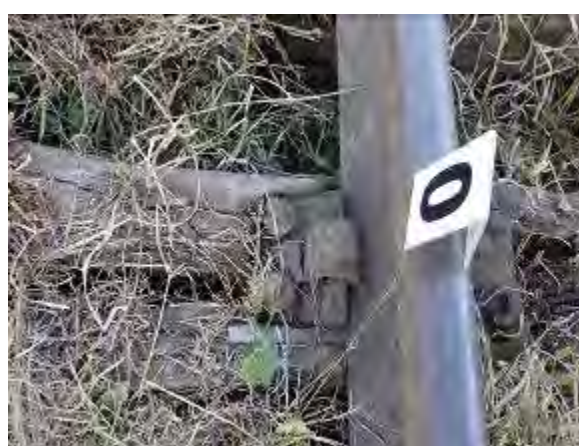
Foto nr.9- traversa „T-1” (exteriorul căii)
