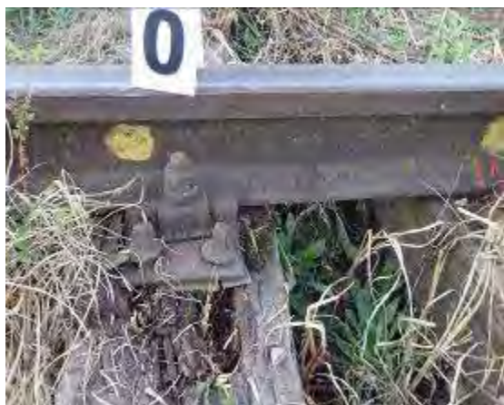
Foto nr.8 - traversa „T-1” (interiorul căii)
