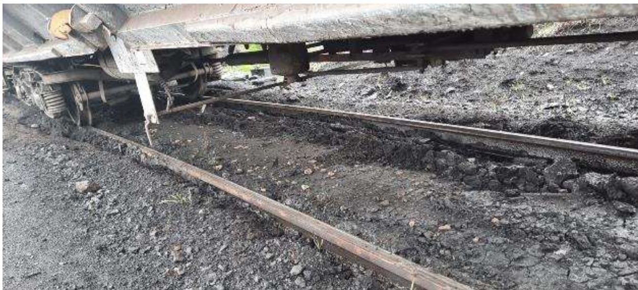
Foto nr.5: Detaliu grad de colmatare a prisme de piatră spartă.
