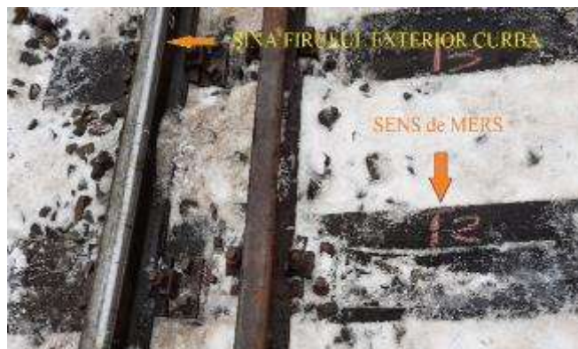
Imaginea 13 – traversa „T 2 ” zona spre fir exterior
