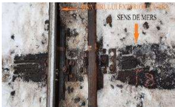
Imaginea 16 – traversa „T 8 ” (pct. de măsurare, 10”)
