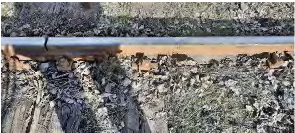
Foto nr.8: starea liniei după deraiere
