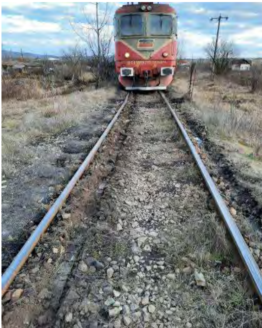
Foto nr.6: starea liniei după deraiere
