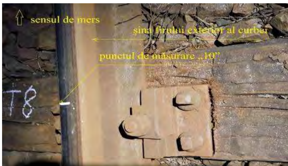
Foto.nr.4 - traversa T_8 și punctul de măsurare „10” marcat pe șina firului exterior
