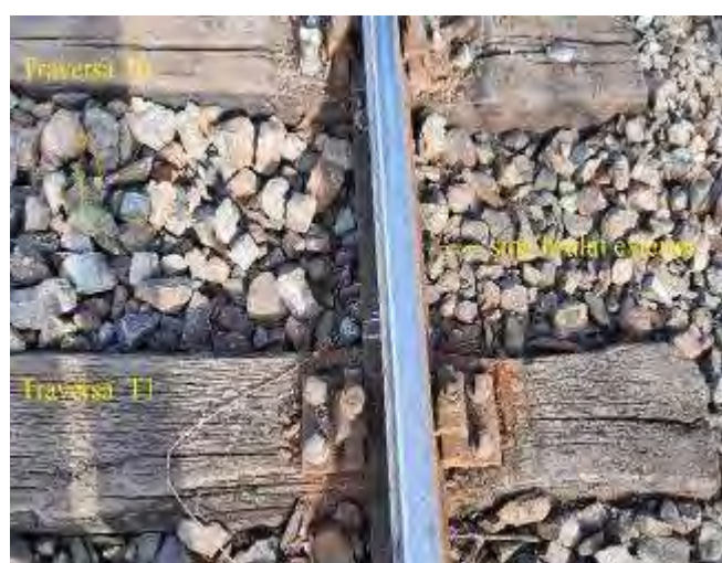
Foto.nr.10 - traversa T_1 și T_0 (după manevrarea plăcilor metalice și redeschiderea circulației)
