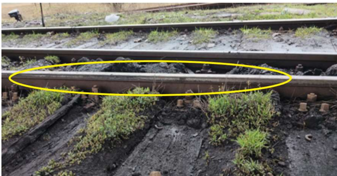
Foto nr.4: urmele create pe suprafața activă a șinei de roata deraiată din partea stângă
