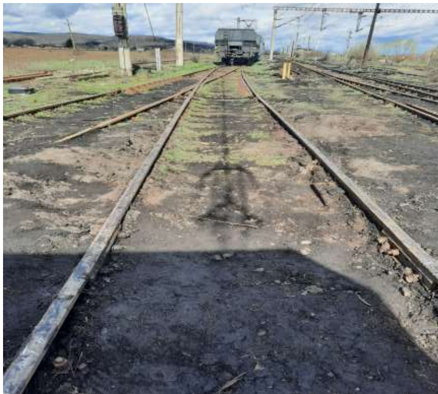
Foto nr.6: Detaliu grad de colmatare a prisme de piatră spartă.
