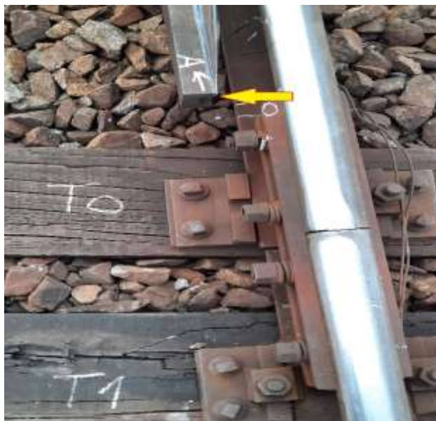
Imaginea nr. 7 - urma de lovire și escaladare a roților din dreapta pe capătul contrașinei – punctul A
