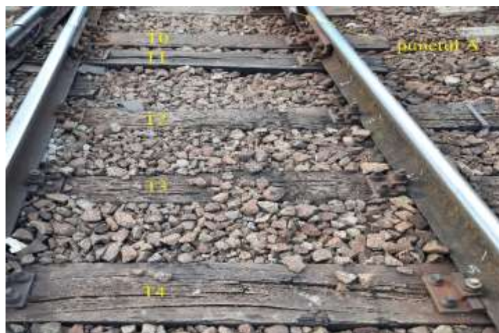
Imaginea nr. 9 – Traversele în zona punctului de deraiere
