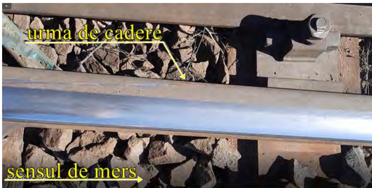
Foto nr.14 punctul de cădere de pe flancul inactiv al acului curb
