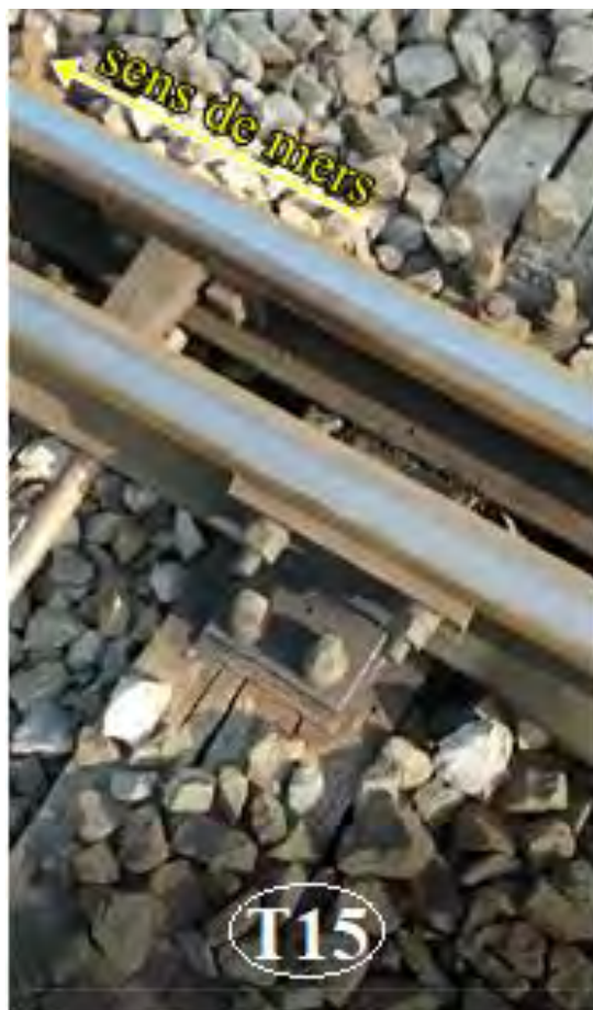
Foto nr.11 - traversa T15 - prinderea placă-traversă pe partea dreaptă
