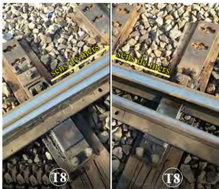
Foto nr.5 - traversa T8 - prinderea placă-traversă pe partea stângă și pe partea dreaptă
