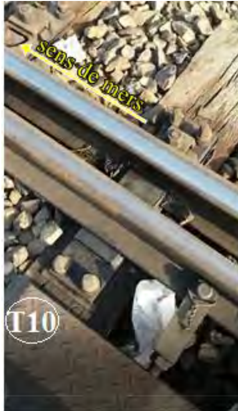
Foto nr.7 - traversa T10 - prinderea placă-traversă pe partea dreaptă
