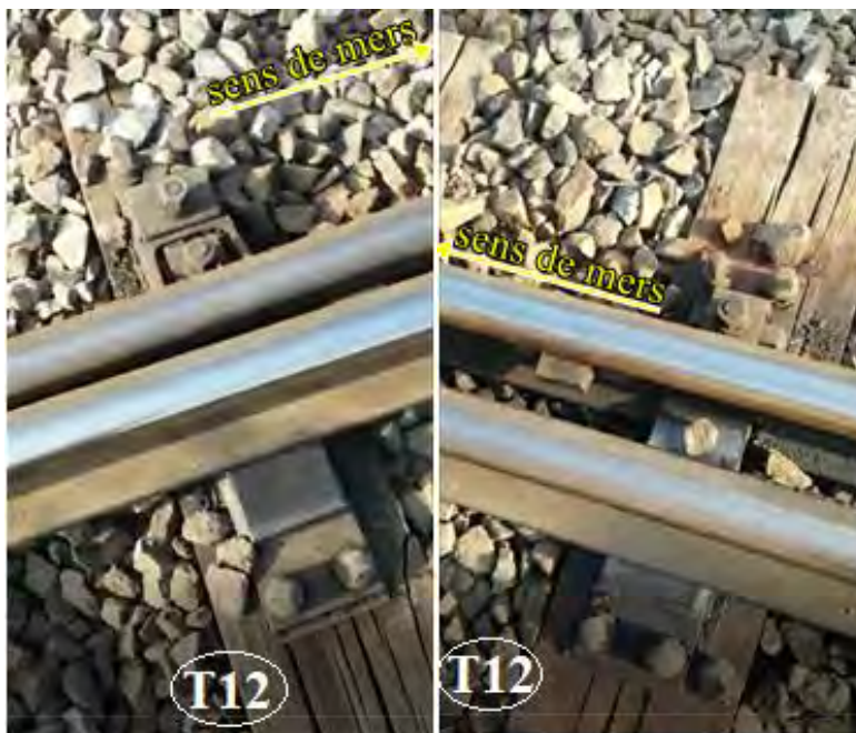
Foto nr.9 - traversa T12 - prinderea placă-traversă pe partea stângă și pe partea dreaptă
